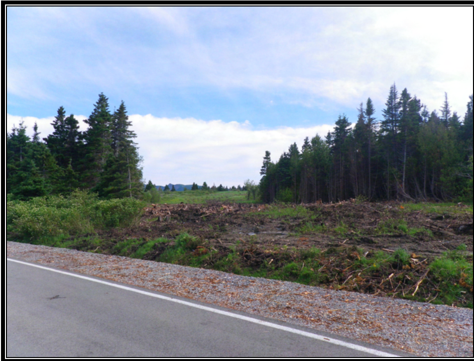
Photo 11 : Vue vers le sud du tronçon projeté #2. Chaînage 304+000. Sondage TA-1.
