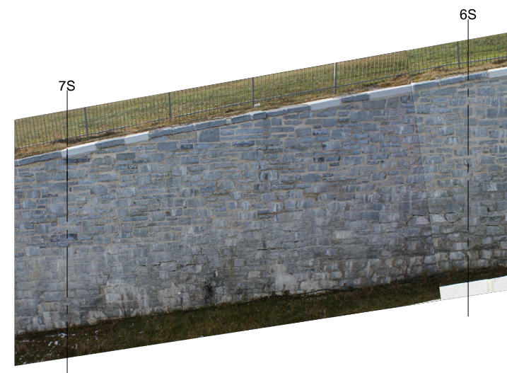
PHOTO 31 - STA. 6S to 7S N.T.S.
