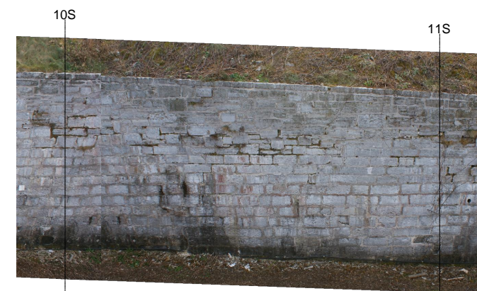
PHOTO 06 - STA. 10S to 11S N.T.S.
