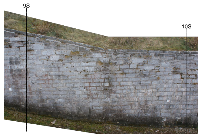
PHOTO 05 - STA. 9S to 10S N.T.S.
