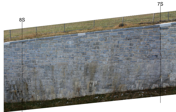
PHOTO 30 - STA. 7S to 8S N.T.S.
