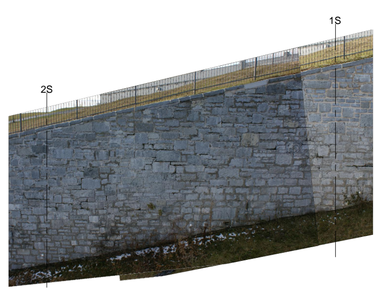
PHOTO 24 - STA. 1S to 2S N.T.S.
