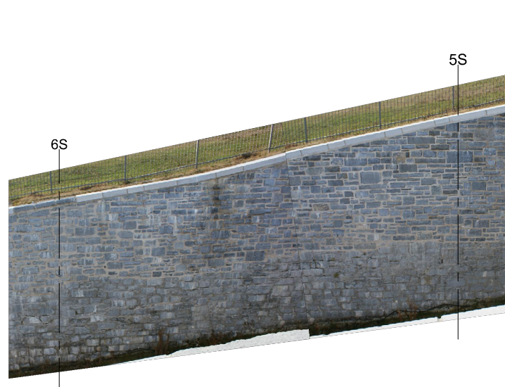
PHOTO 26 - STA. 5S to 6S N.T.S.
