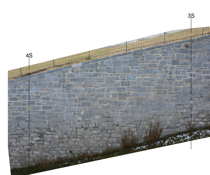
PHOTO 28 - STA. 3S to 4S N.T.S.
