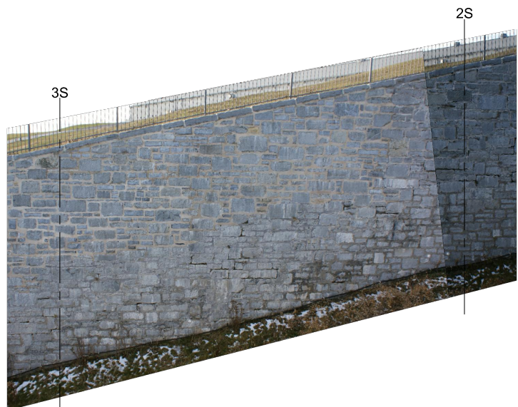
PHOTO 23 - STA. 2S to 3S N.T.S.
