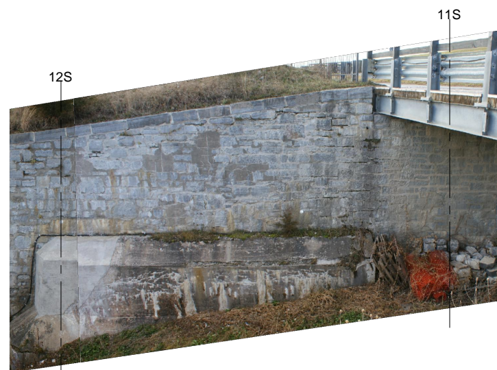
PHOTO 32 - STA. 11S to 12S N.T.S.
