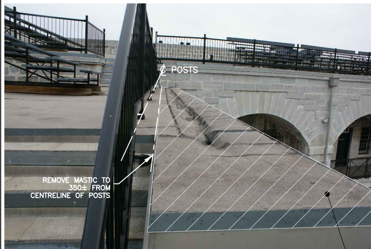
EXISTING GUTTER N.T.S.
