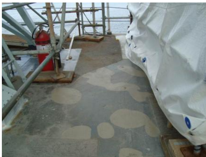
Revêtement antidérapant manquant sur le pont supérieur de la passerelle
