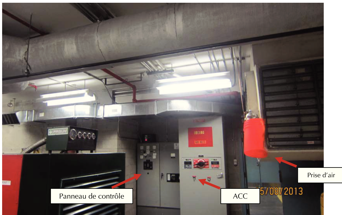
3 – Panneau de contrôle de la génératrice, AAC existant et prise d'air
