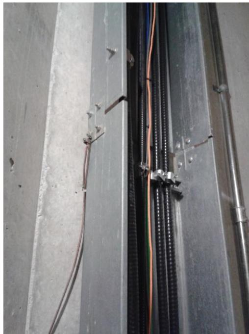
**Figure 19: Chemin de câble vertical, intérieur de la tour**
