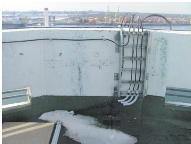
**Figure 28: Chemin de câble, palier supérieur**
