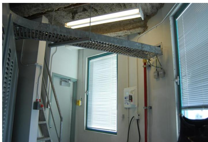
**Figure 33: Entrée des câbles, salle de télécommunications**
