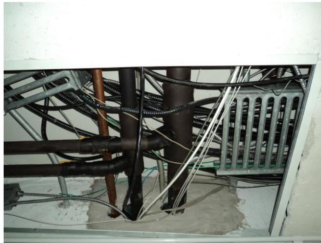
**Figure 7: Passage des câbles au plafond**
