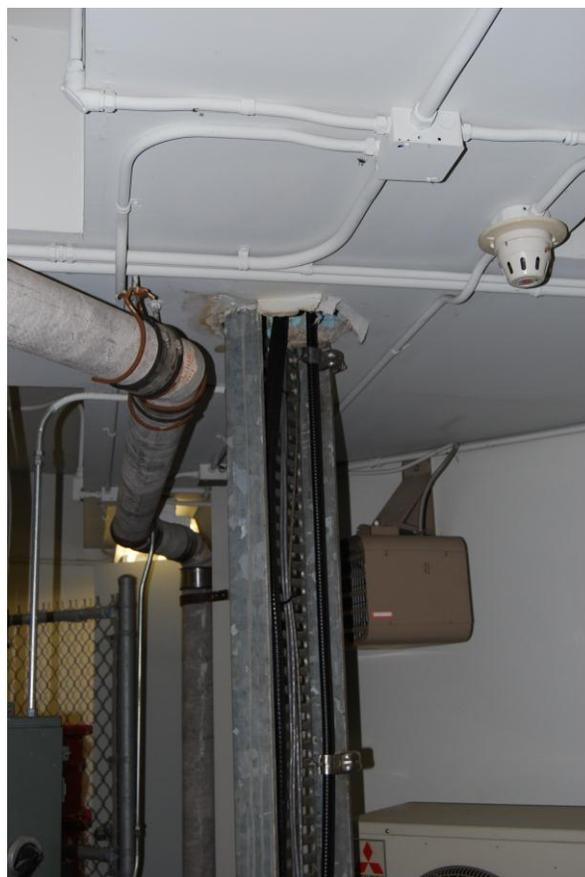
**Figure 35: Chemin de câble vertical, salle mécanique**
