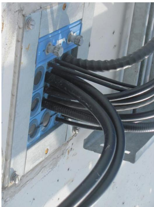
**Figure 30: Entrée des câbles, palier intermédiaire**
