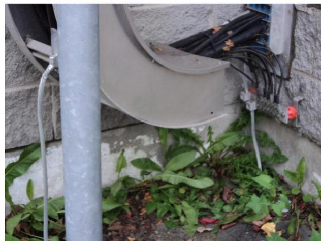
**Figure 5: Entrée des câbles extérieure**
