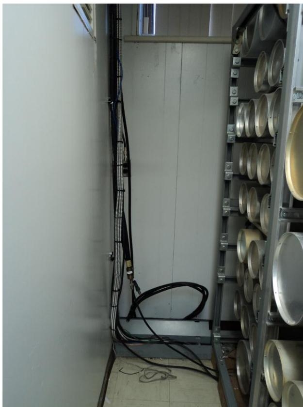
**Figure 9: Descente des câbles vers le caniveau**
