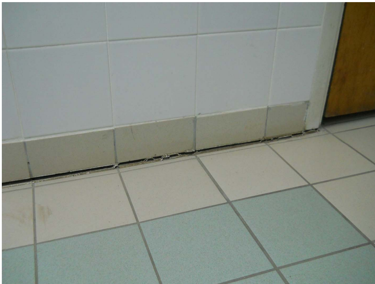
Photographie n° 1 – Désolidarisation du mur intérieur et de la dalle sur sol des salles de bain.
