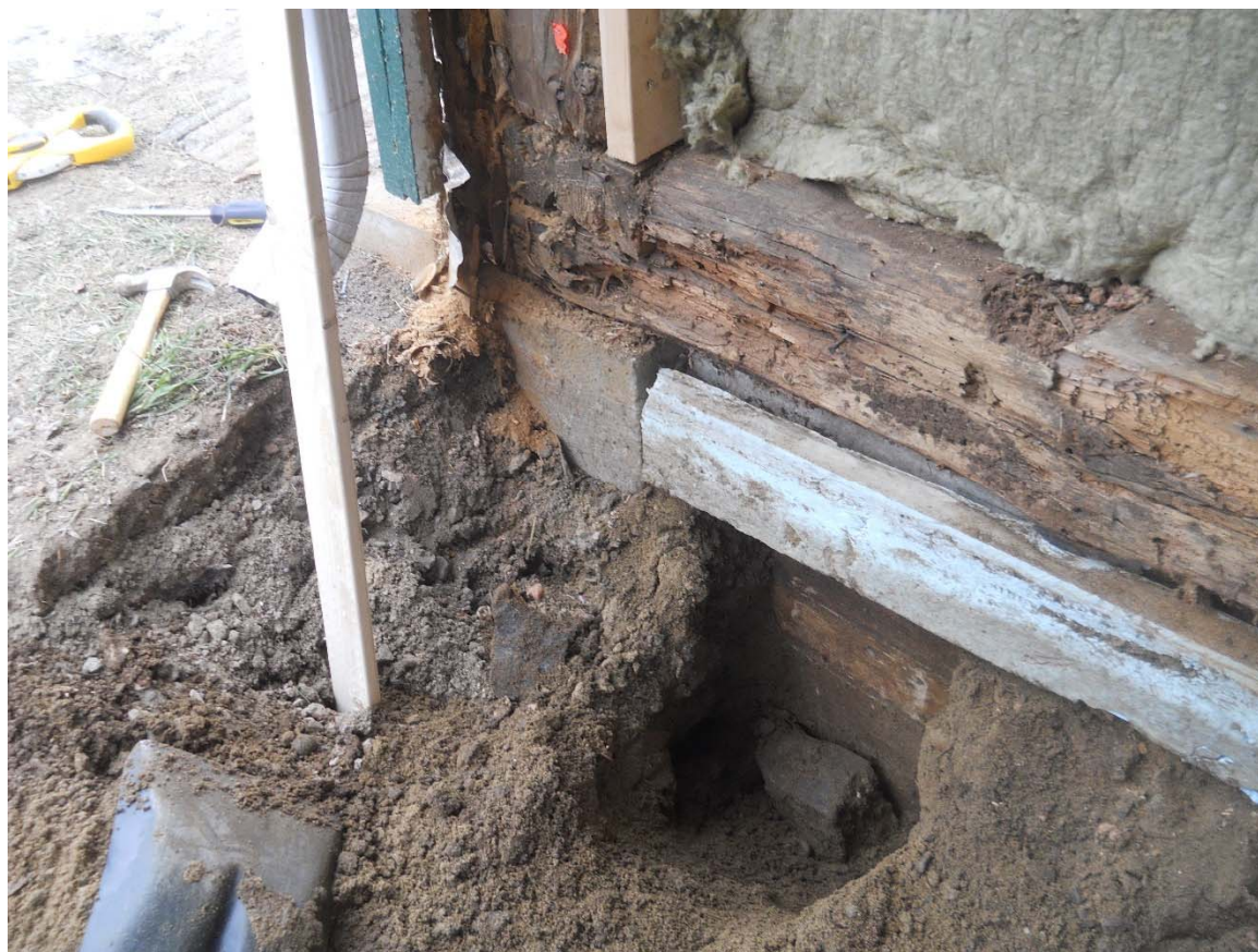
Photographie n° 3 – Coin nord-est du bâtiment (salles de bain) avec une partie de la fondation qui a été dégagée.
