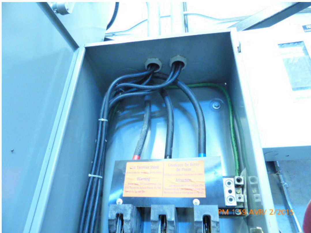
Photo n° 2 – Intérieur de l'interrupteur
