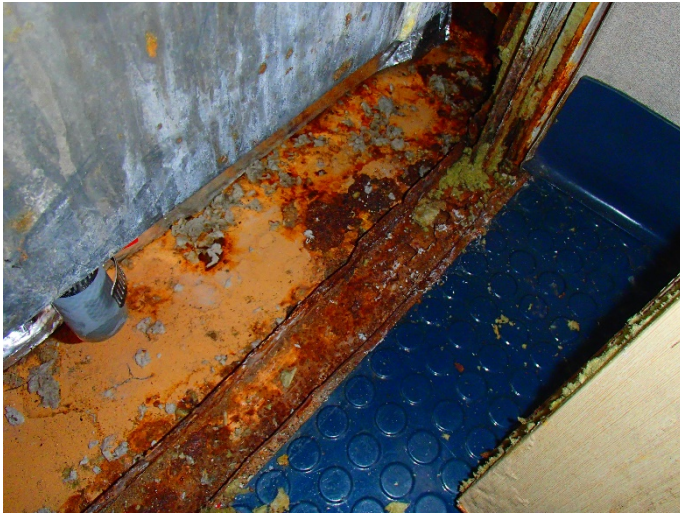
Figure 13 : Rigole de fixation et plancher corrodé
