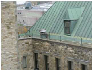
Roof Exhaust Fan
