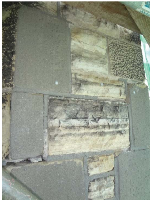
Photo n° 6: Joints ouverts et produit de resurfacement employé
