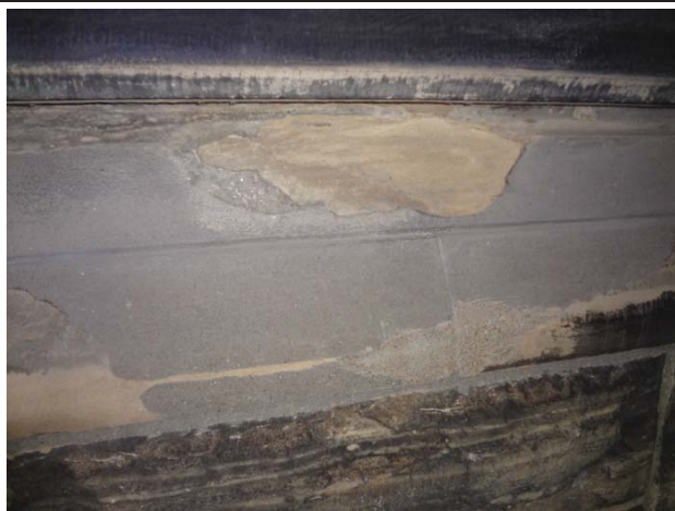
Photo n° 4: Délamination de la réparation et pierre érodée sous la surface
