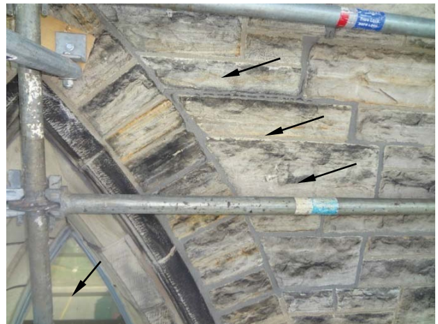
Photo n° 5: Dépôt sur la pierre et surface érodée
