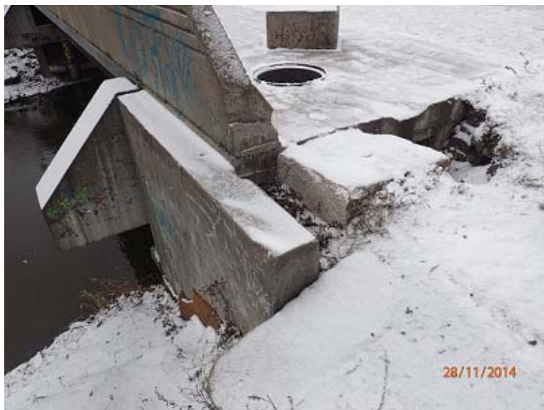
Photographie 22 : Approche du pont – Remblais manquant
