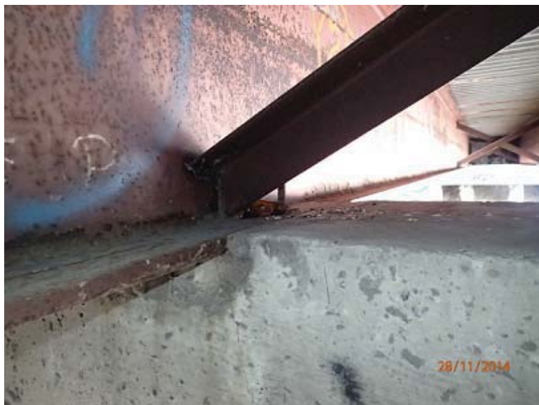
Photographie 12 : Quelques contreventements en « X » soudés non correctement
