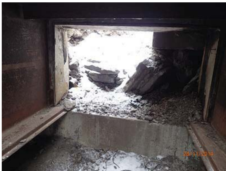
Photographie 21 : Mur de béton – Ouverture 800mm de hauteur à refermer
