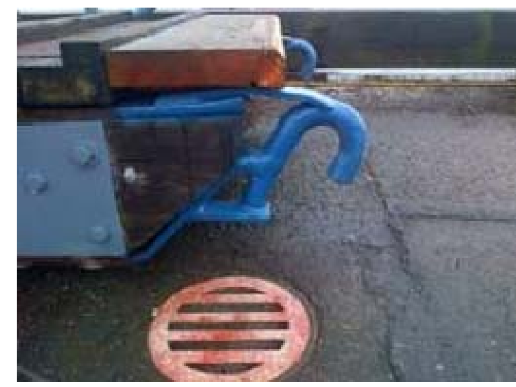
EXISTING GANGWAY HINGE DETAIL
