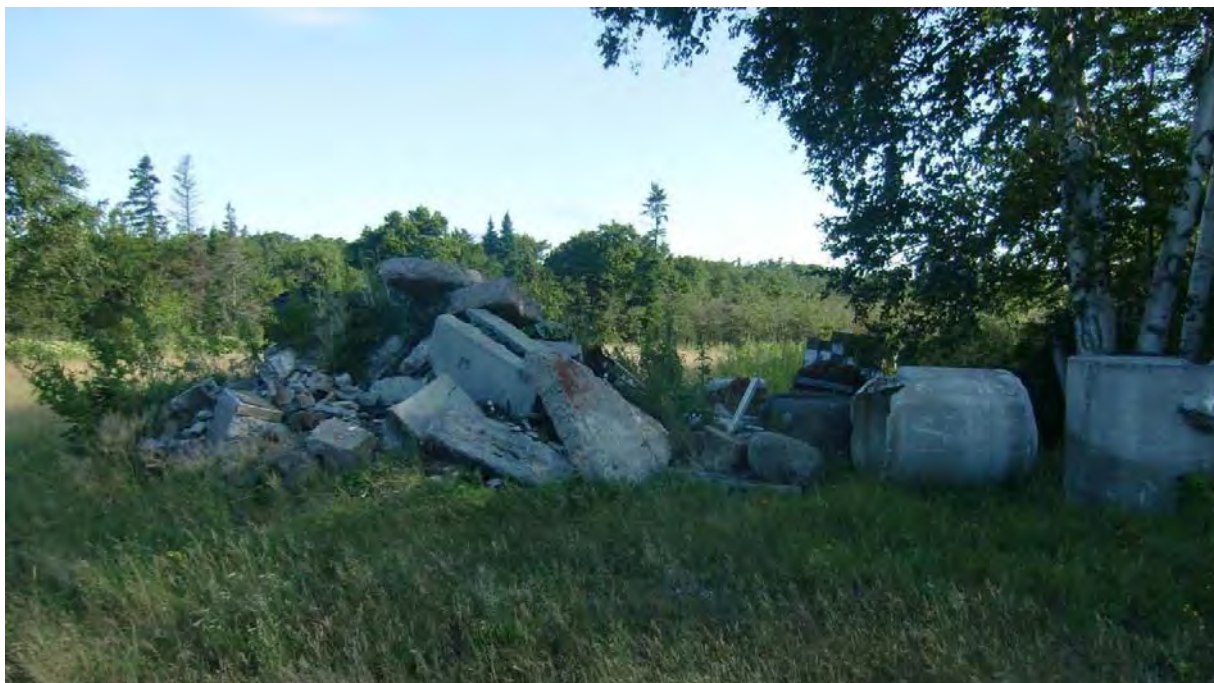
Photo 7 : Vue de l'empilement C composé de ferraille, de béton et de briques. Vue vers l'est.
