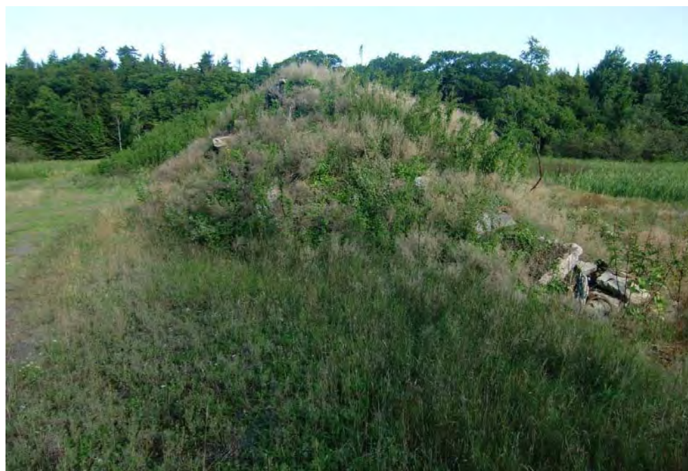
Photo 4 : Vue de l'empilement B composé de déchets solides. Vue vers le nord-ouest.
