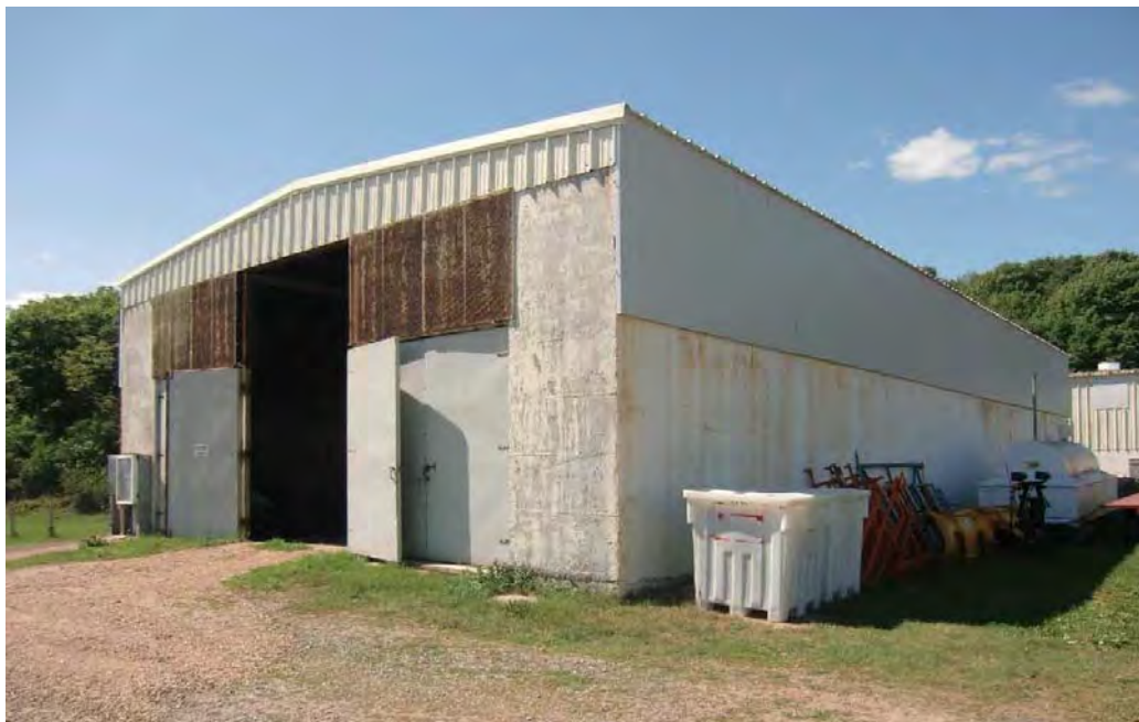
Photo 11 : Vue du hangar où sont entreposés les sols contaminés de l'empilement E. Vue vers l'ouest.
