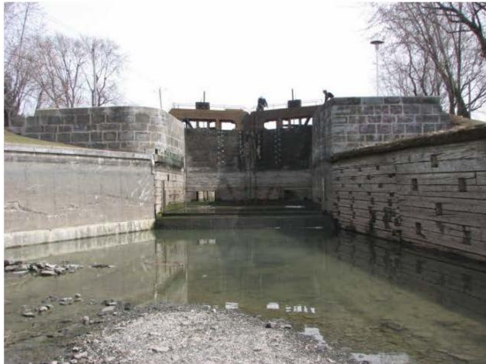
Photo 2 - Face aval des portes
