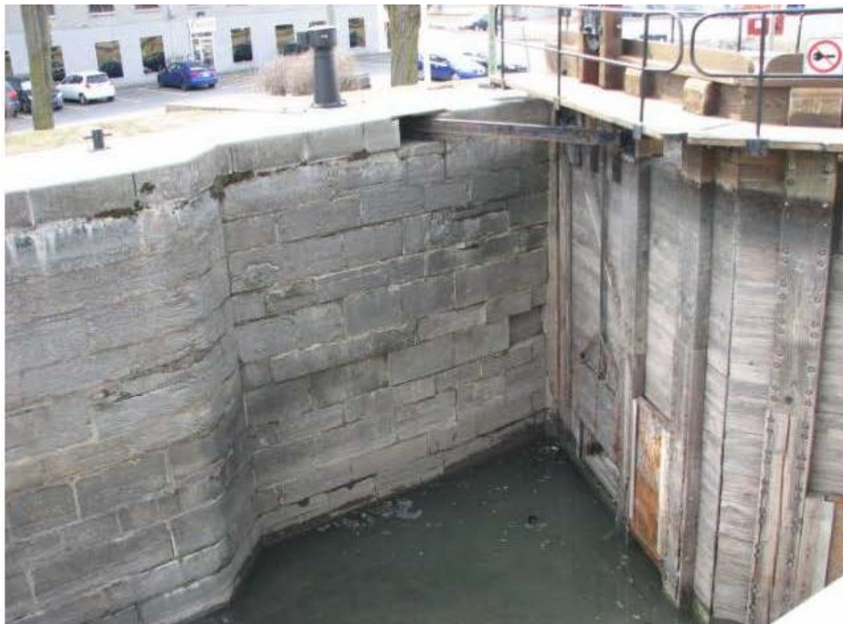
Photo 4- Mécanisme d'ouverture de la porte en rive gauche
