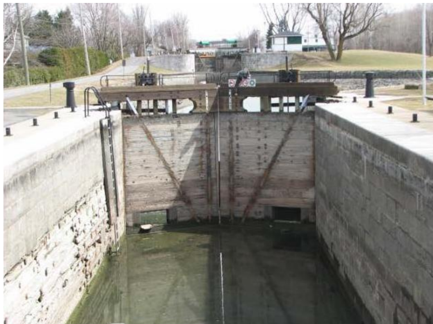
Photo 5 - Face aval des portes
