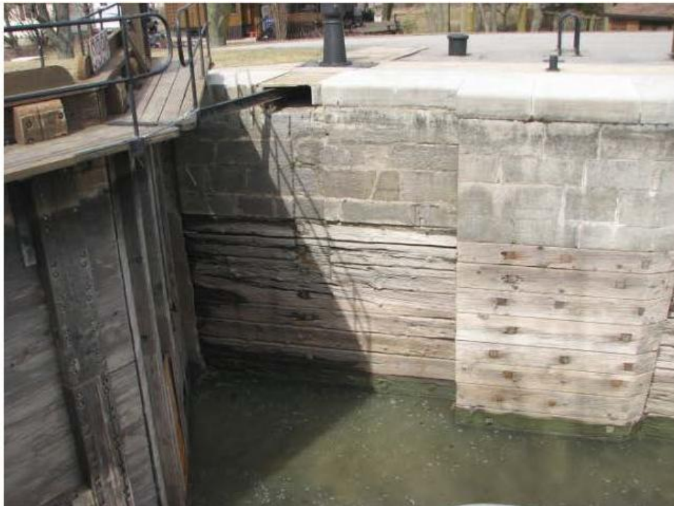
Photo 3 - Mécanisme d'ouverture de la porte en rive droite
