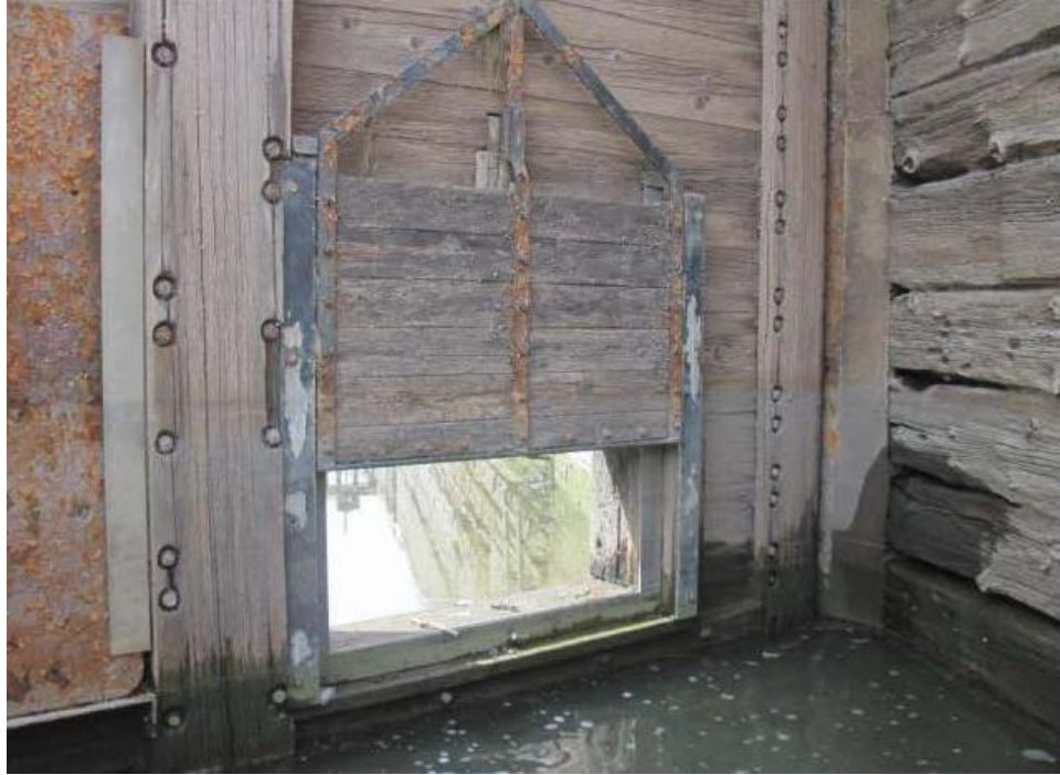
Photo 2 - Vanne guillotine en rive droite
