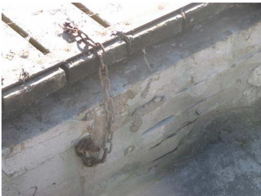
Photo 9 - Attache du platelage de puits de crémaillère
