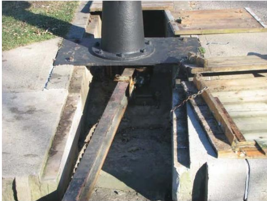
Photo 8 - Puits de crémaillère en rive droite
