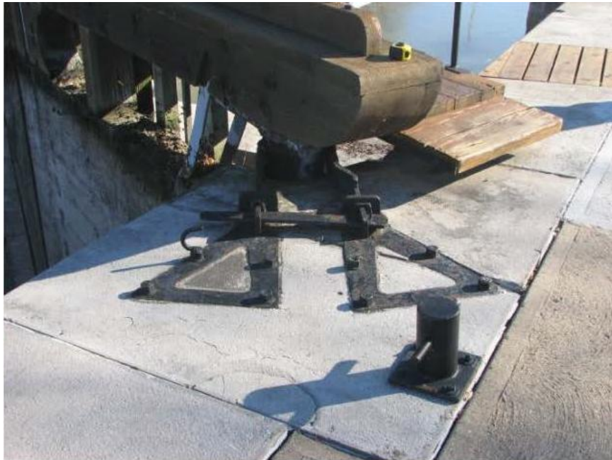
Photo 6 - Pivot supérieur et principe d'attache du collet en rive gauche
