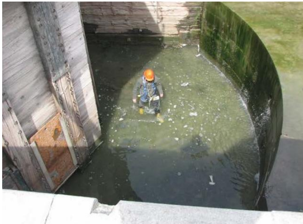
Photo 3 - Partie du canal à l'amont des portes
