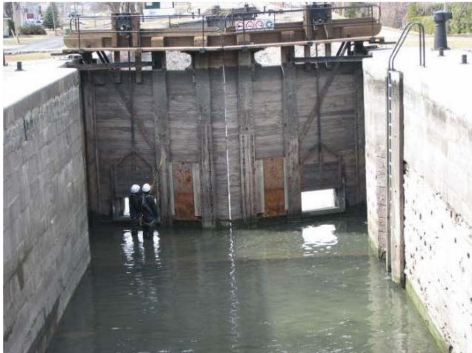
Photo 1 - Face amont des portes
