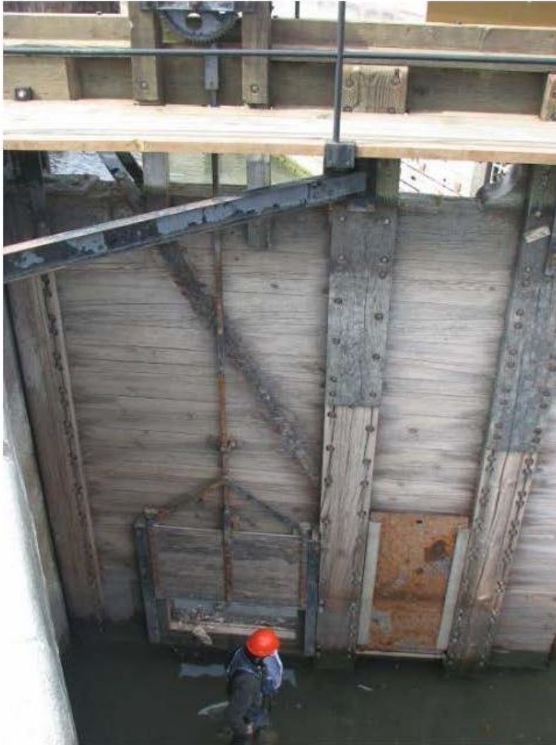
Photo 1 - Porte rive gauche
