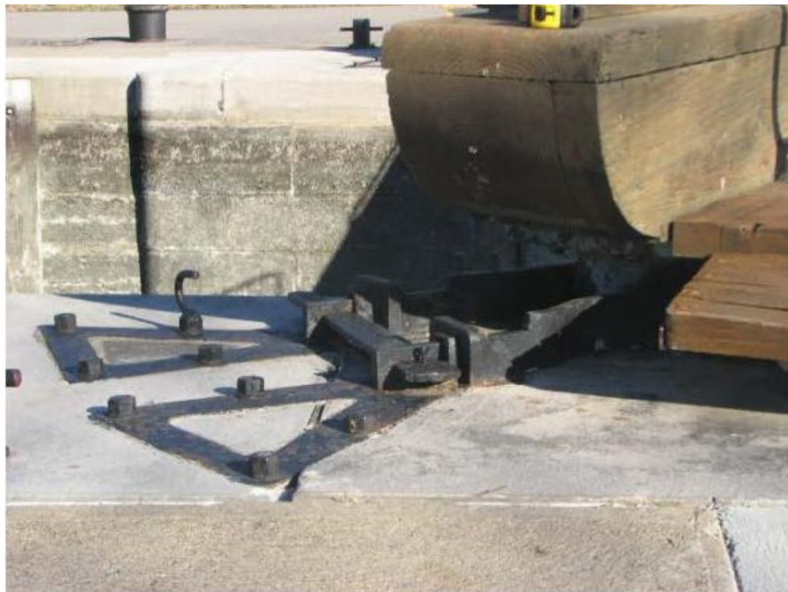
Photo 7 - Principe d'attache du collet en rive gauche
