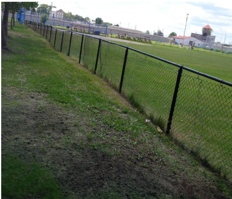
PHOTO 1 : Section de clôture de 4' à démolir et remplacer par une 8', longueur approximative de 51000 (voir agrandissement 2 à la page A2/2 des plans).
