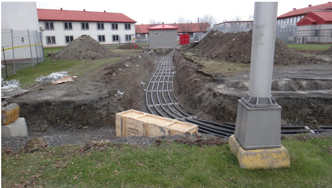
PHOTO 2 : Section de tranchée existante où porter une attention particulière entre les bâtiments 10 et 8 (voir agrandissement 2 à la page A2/2 des plans).
