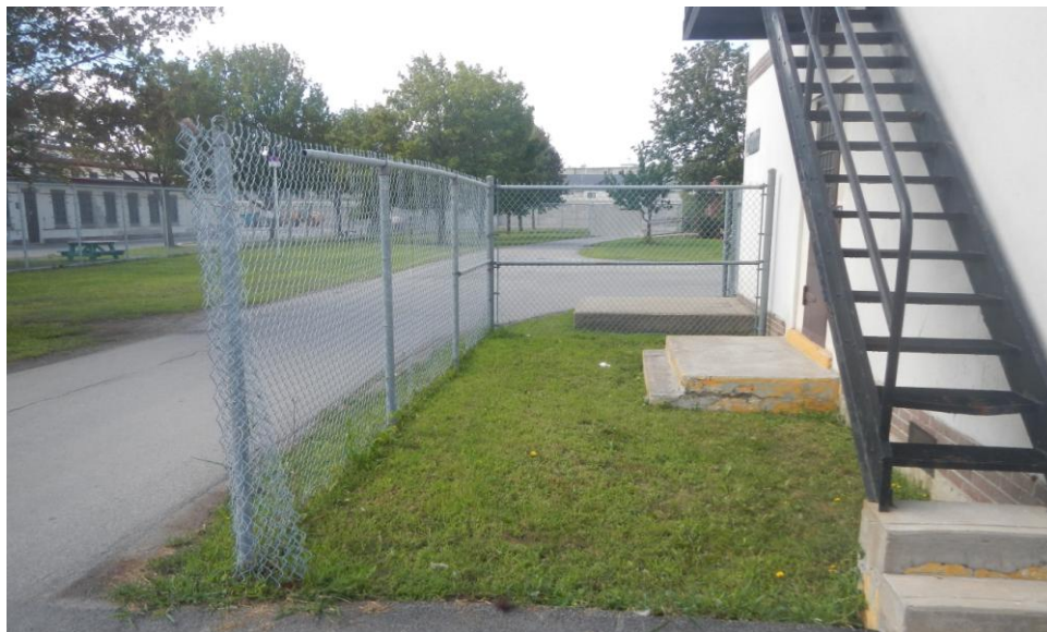
PHOTO 3 : Section de clôture de 6' à démolir, longueur approximative de 10350 (voir agrandissement 3 à la page A2/2 des plans).
