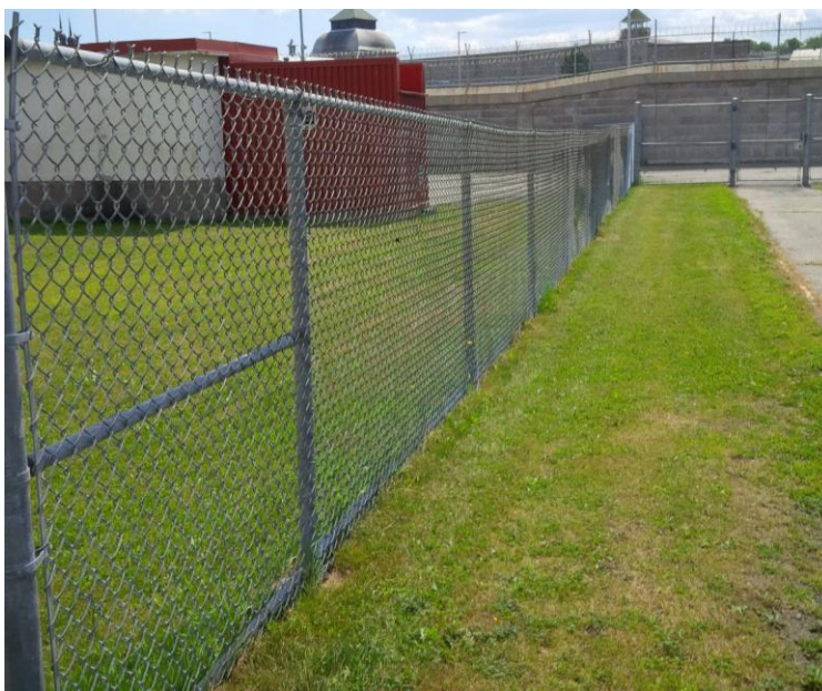
PHOTO 2 : Section de clôture de 6' à démolir et remplacer par une 8', longueur approximative de 28500 (voir agrandissement 2 à la page A2/2 des plans).
