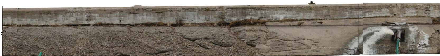
BIEF 4 - SUD - 04 - C
