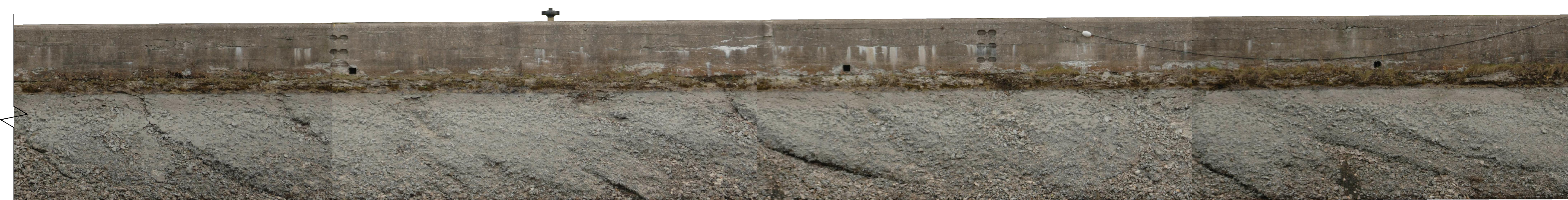
BIEF 4 - SUD - 09 - C
