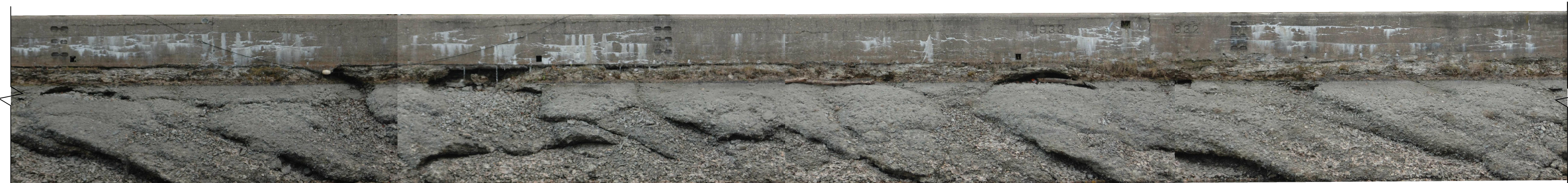
BIEF 4 - SUD - 06 - C
