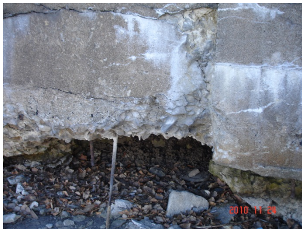
Photo 08 - Vue typique des dommages à réparer
