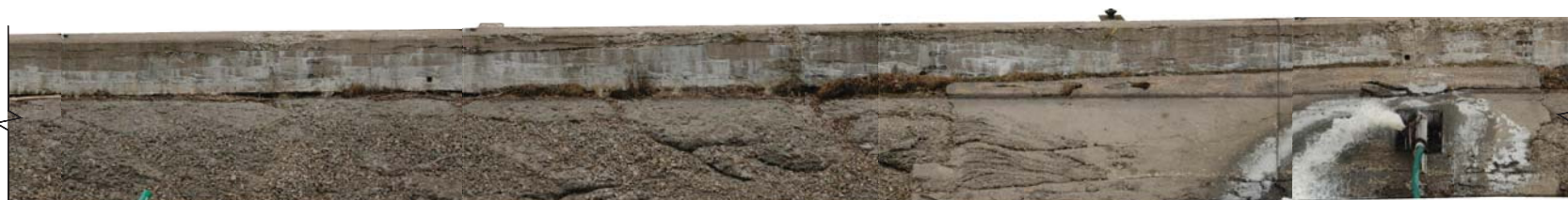
BIEF 4 - SUD - 04 - C
