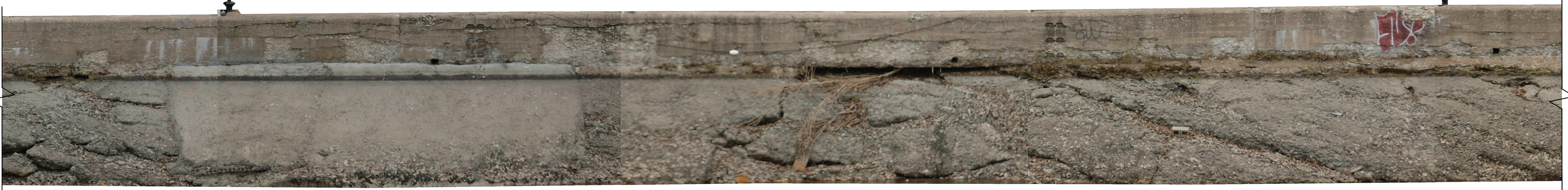
BIEF 4 - SUD - 03 - C 1 : 50
