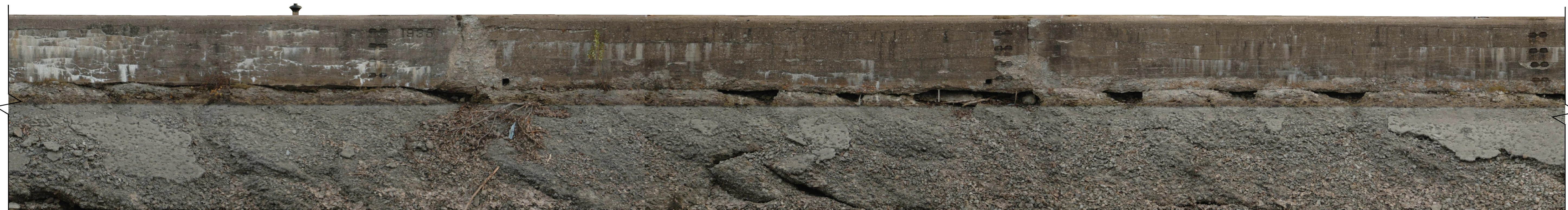
BIEF 4 - SUD - 15 - C
