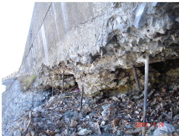
Photo 12 - Vue typique des dommages à réparer
