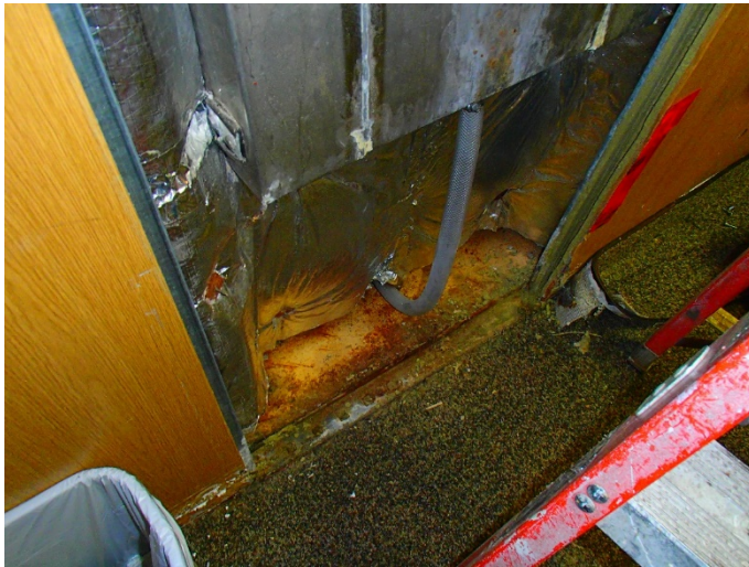
Figure 10 : tuyau de drainage du bassin sous la fenêtre
