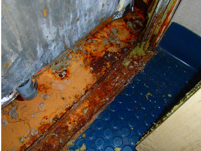
Figure 8 : Rigole de fixation et plancher corrodé
