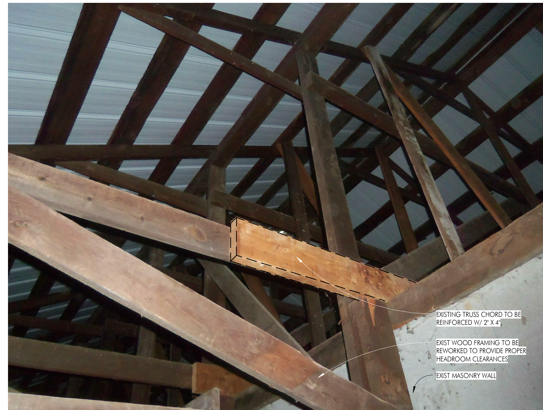
EXIST WOOD TRUSS BOTTOM CHORD SCALE: N.T.S.
