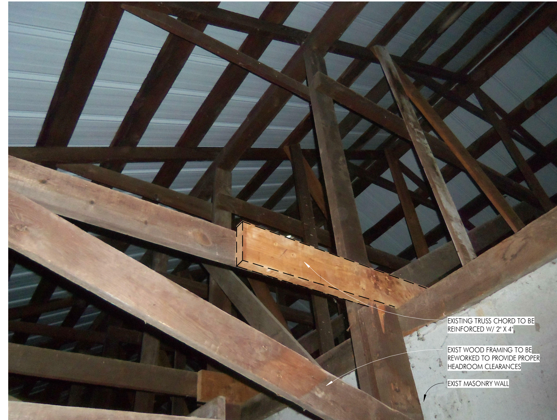
EXIST WOOD TRUSS BOTTOM CHORD SCALE: N.T.S.
