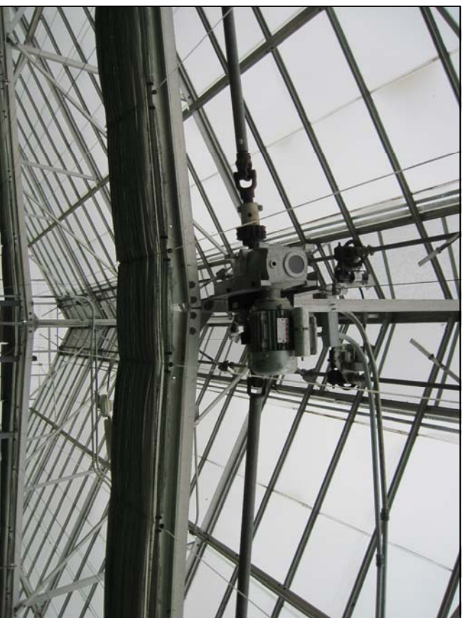
MOTEUR D'ENTRAÎNEMENT DE LA SERRE 1
