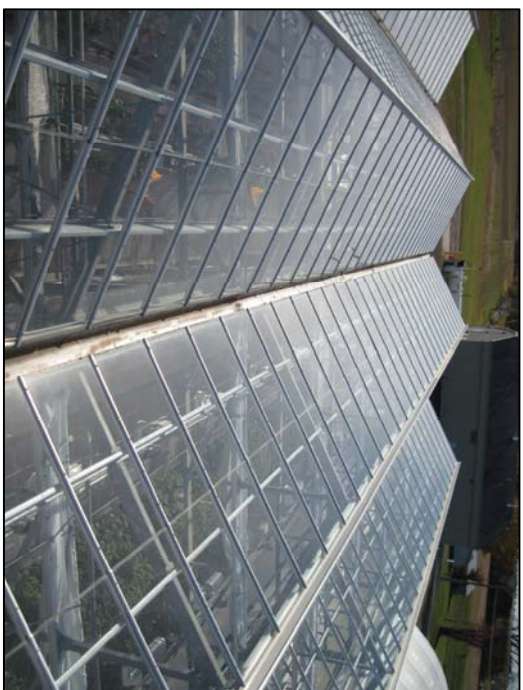
VUE EXTÉRIEURE DU DESSUS ENTRE LES SERRES 2 ET 3
