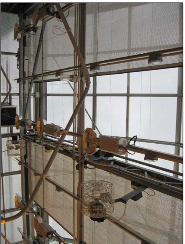
VUE TYPIQUE D'UN ÉCRAN PARTIELLEMENT FERMÉ
