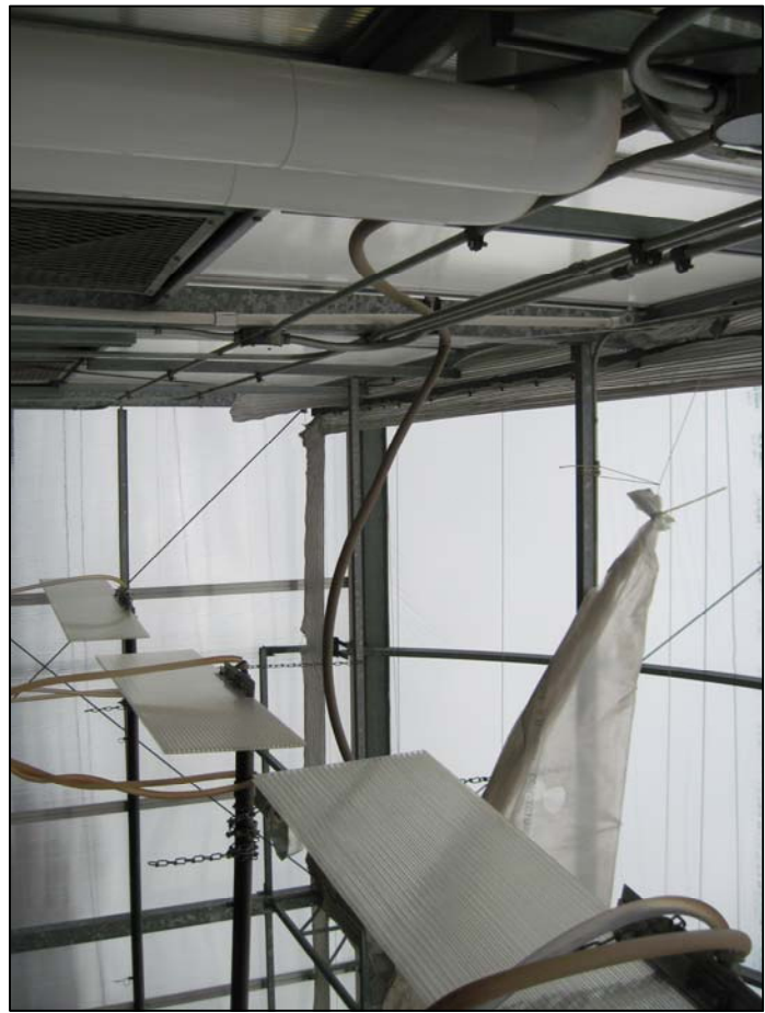
VUE INTÉRIEURE DE LA SERRE 6, ORIENTATION VERS L'OUËST
