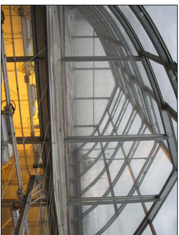
VUE TYPIQUE DU VIDE DU PLAFOND
