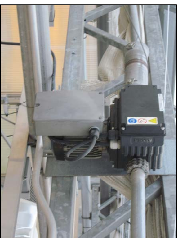
MONTAGE TYPIQUE DU MOTEUR D'ENTRAÎNEMENT DE LA SERRE
