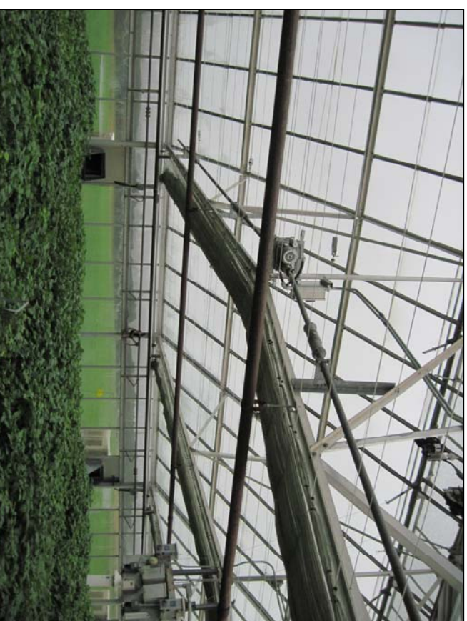
MONTAGE DE L'ARBRE D'ENTRAÎNEMENT DANS LA SERRE 1
