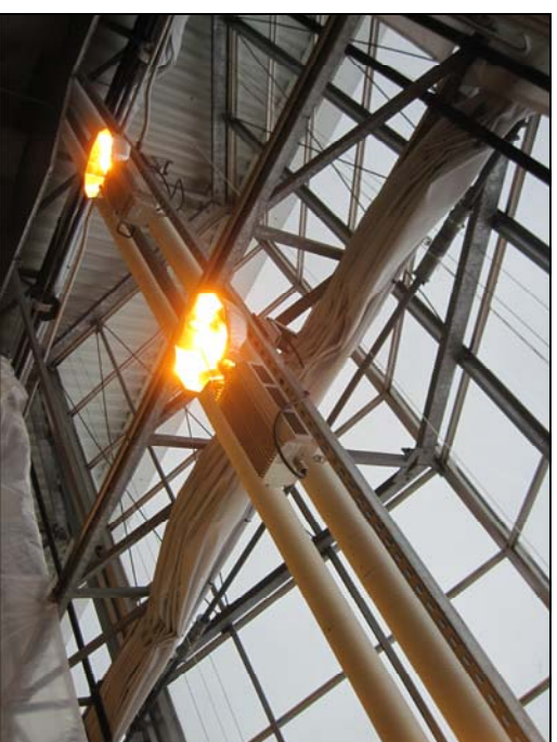
MONTAGE TYPIQUE DE L'ARBRE D'ENTRAÎNEMENT DES SERRES 2 ET 3
