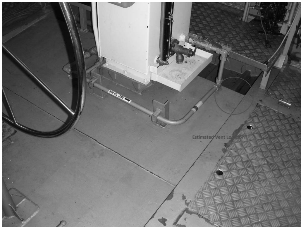
Figure H-02-2 Emplacement proposé de l'évent du réservoir de carburant n° 9
