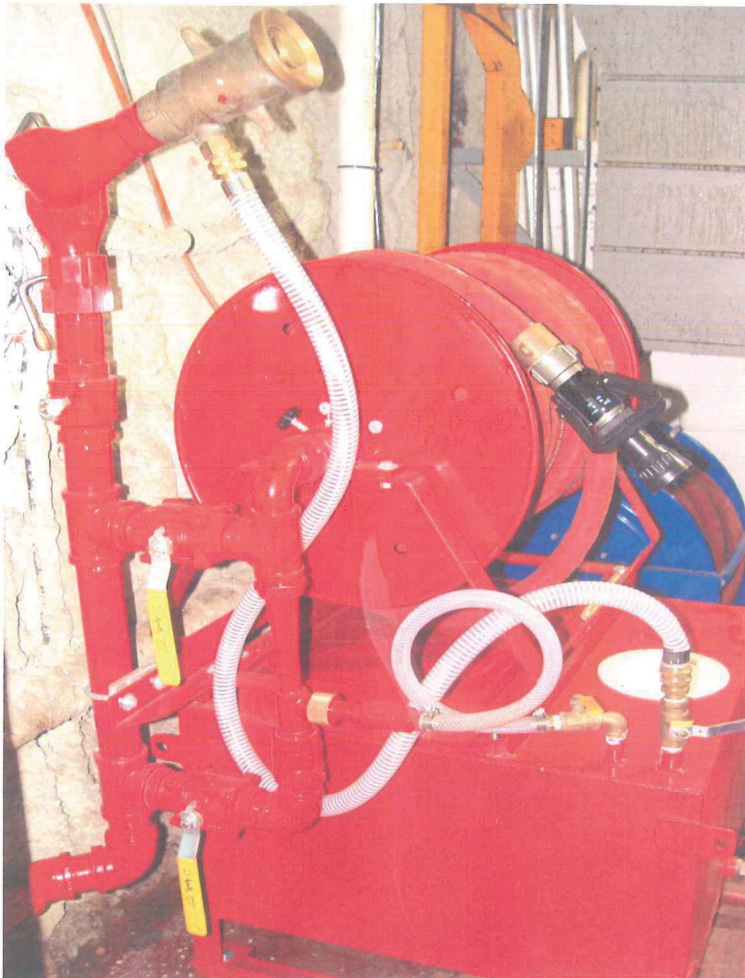
Système d'extinction hangar d'hélicoptère Minuteman II model 150
