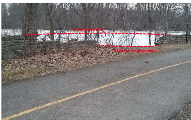
Figure 2 : Instabilité probable à l'endroit du mur de la culée est
