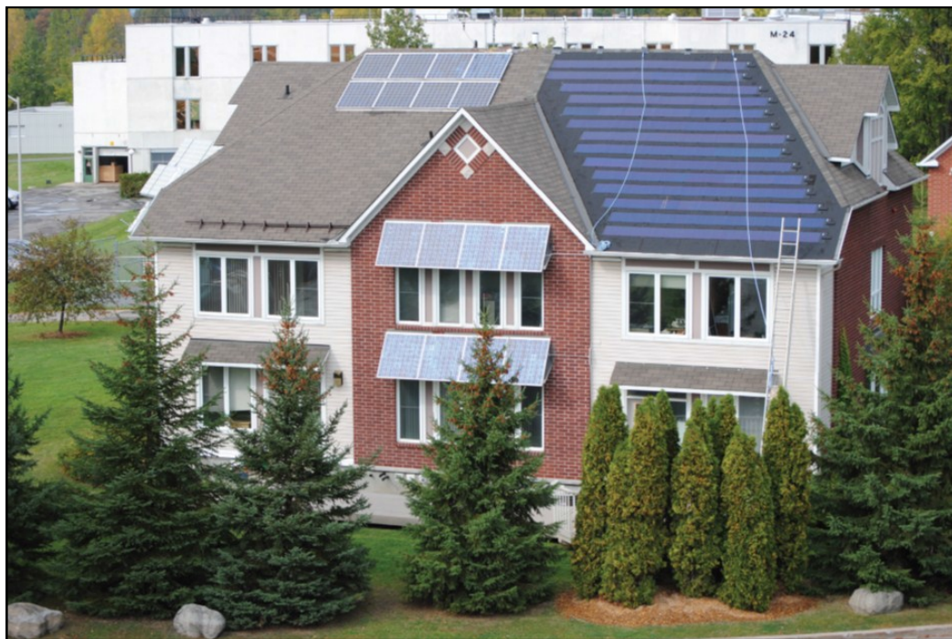
Un système photovoltaïque intégré sur le toit de l'InfoCentre du CCTR. L'InfoCentre comprend aussi la maison Bâti-Flex MC .
