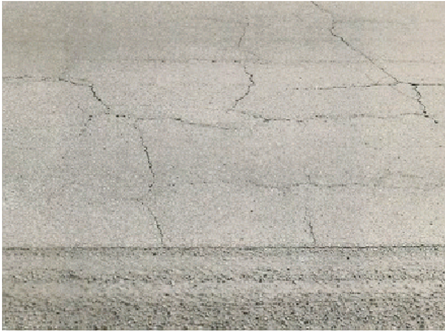
Figure 2.7.1(d) Light Map Cracks
