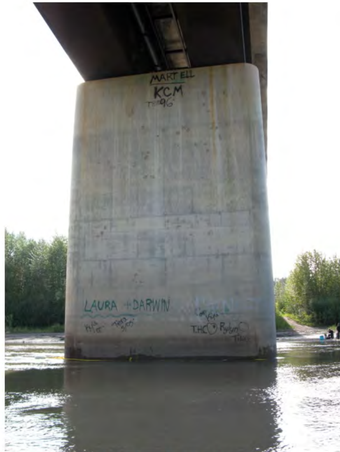
UW04 - Pier 3 HC face
