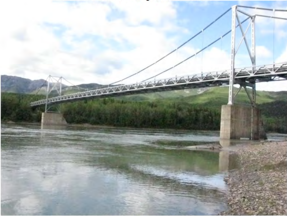
UW01 - Pier 2 DS nose looking US
