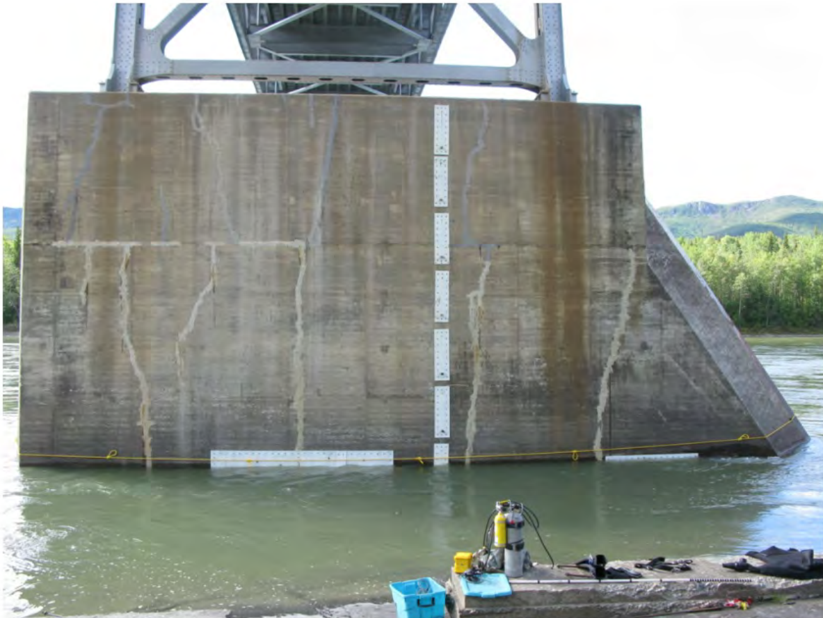
UW12 - Pier 2 HC face 2
