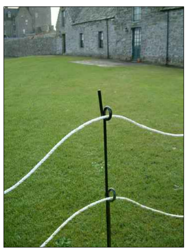
POST AND DOUBLE ROPE EXAMPLE / EXEMPLE DE TIGE EN ACIER AVEC DEUX CORDES
