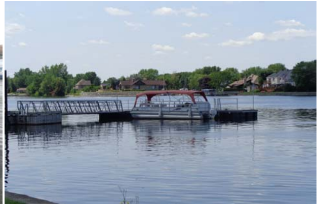
Figure 4 Quai du débarcadère (rampe et quais flottants), Quai B
