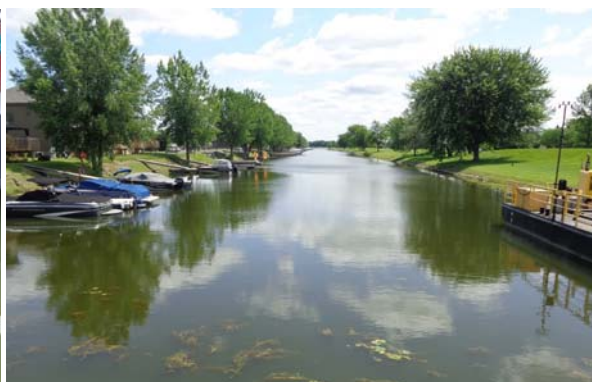
Figure 2 Nouveaux quais flottants, côté est du canal, Quai A
