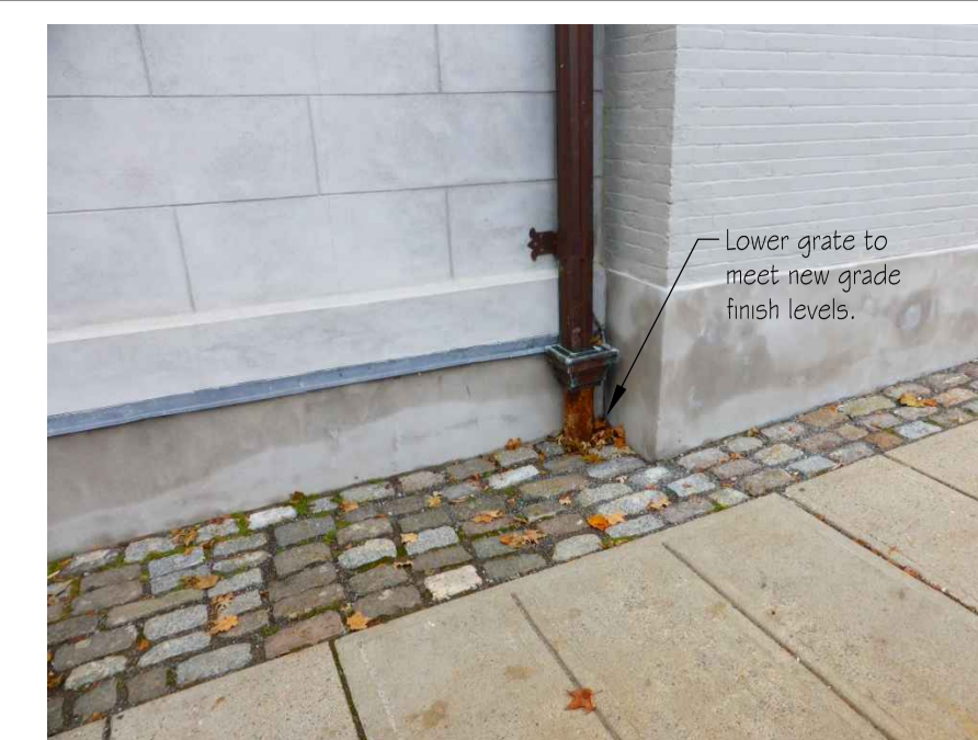
DS01 A101 Photo of Existing Downspout Grate Photo de la grille de la descente pluviale existante Scale / échelle : NTS
