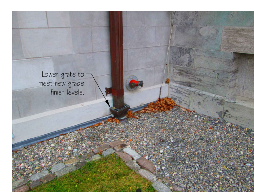
DS03 A101 Photo of Existing Downspout Grate Photo de la grille de la descente pluviale existante Scale / échelle : NTS
