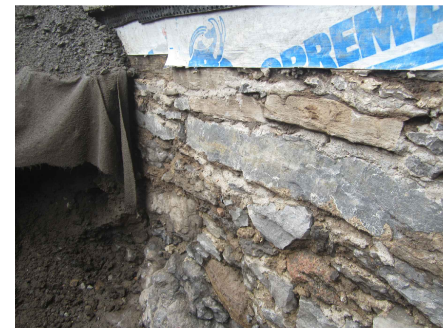
04 A101 Photo of Foundation Wall Photo du mur de fondation Scale / échelle : NTS
