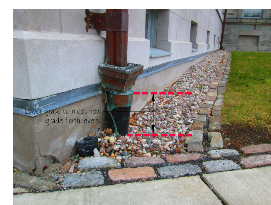
DS02 A101 Photo of Existing Downspout Grate Photo de la grille de la descente pluviale existante Scale / échelle : NTS
