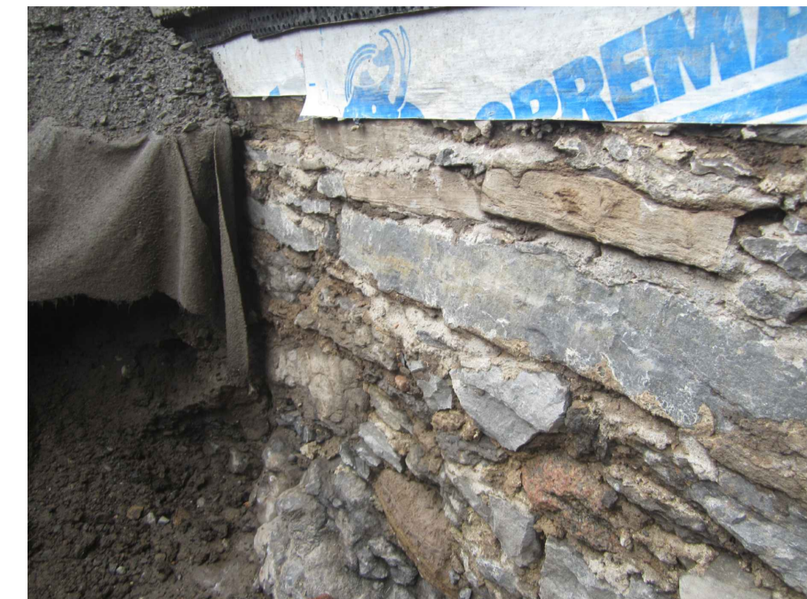
04 Photo of Foundation Wall Photo du mur de fondation Scale / échelle : NTS
