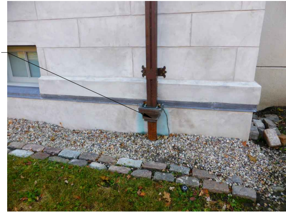
DS05 Photo of Existing Downspout Grate Photo de la grille de la descente pluviale existante Scale / échelle : NTS
