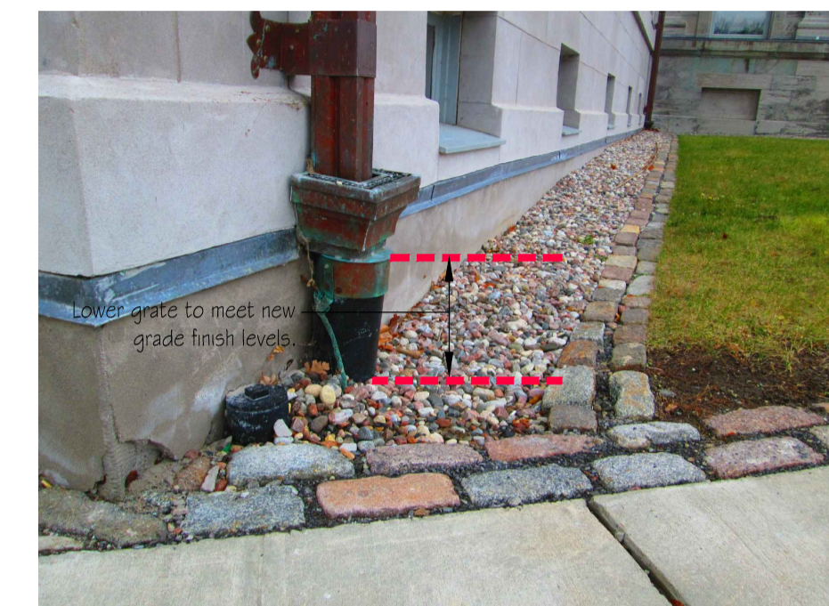
DS02 Photo of Existing Downspout Grate Photo de la grille de la descente pluviale existante Scale / échelle : NTS
