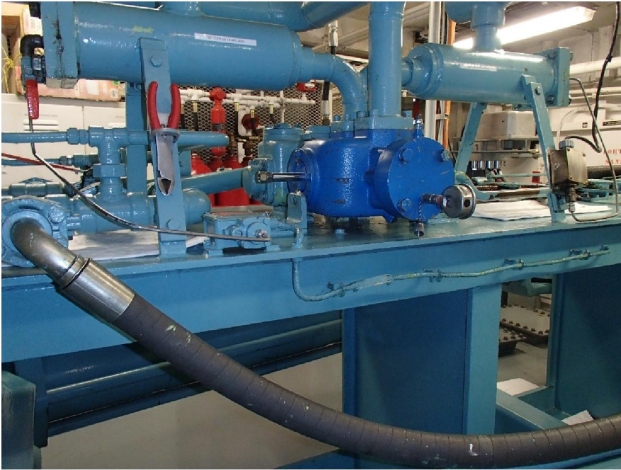
Photo no. 31 : Radisson 4-Way Valve – Soupape 4 voies
