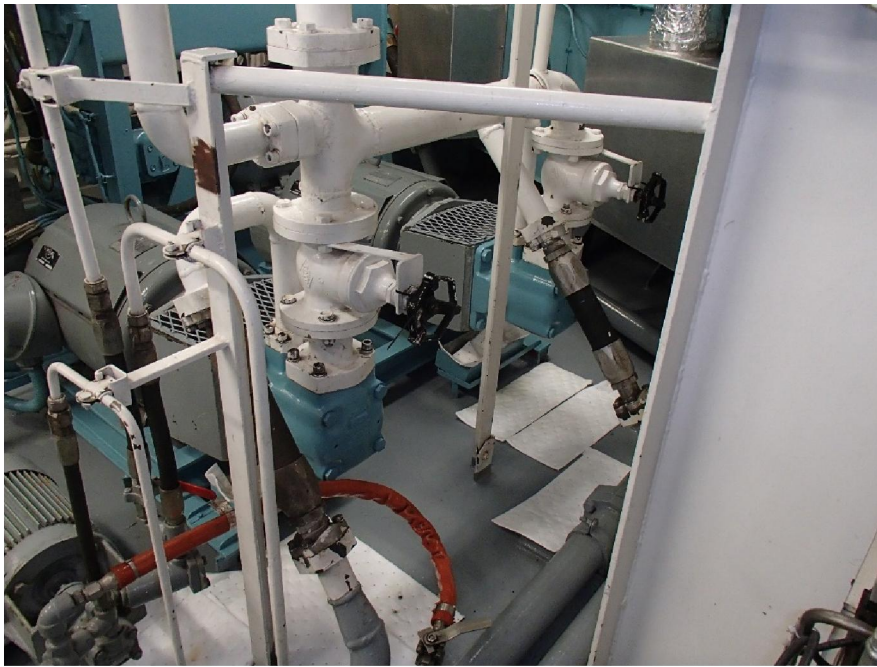
Photo no. 13 : Radisson Power Pumps – Pompes puissance principales
