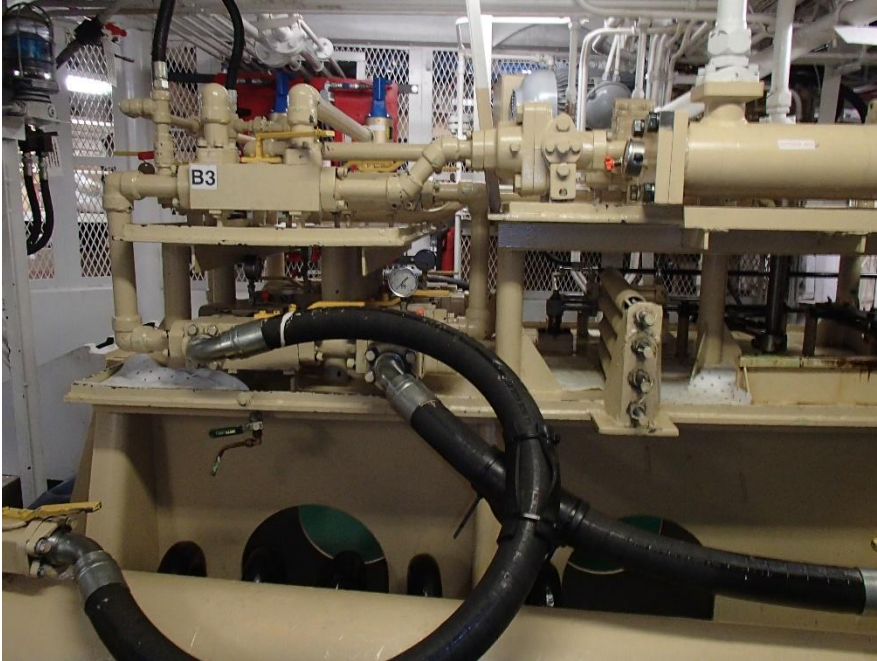
Photo no. 33 : Des Groseilliers 4-Way Valves – Soupapes 4 voies
