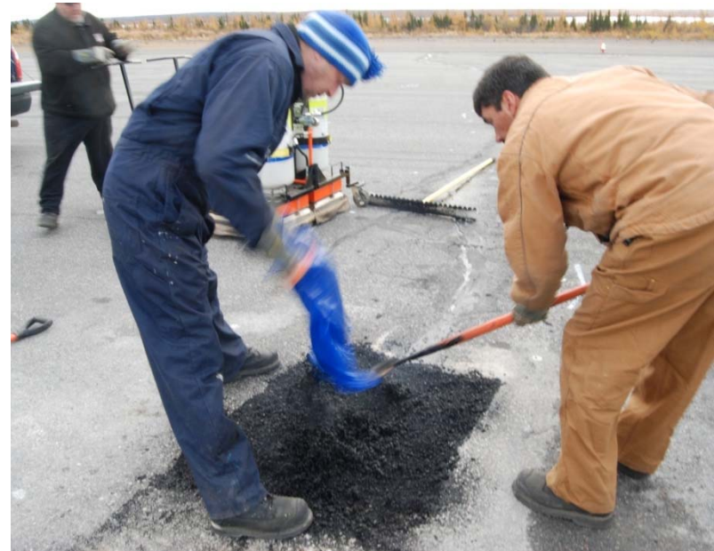
Ajout de matériaux de pavage à froid/ Cold patch mix materials added
