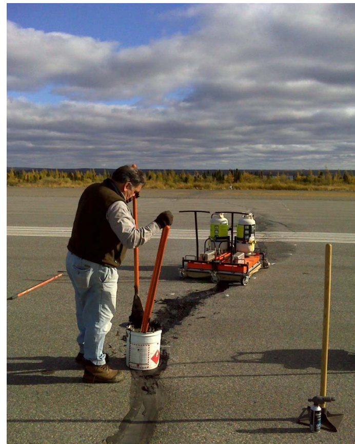
Enlèvement du matériel de scellement de fissure / Crack filling material removal
