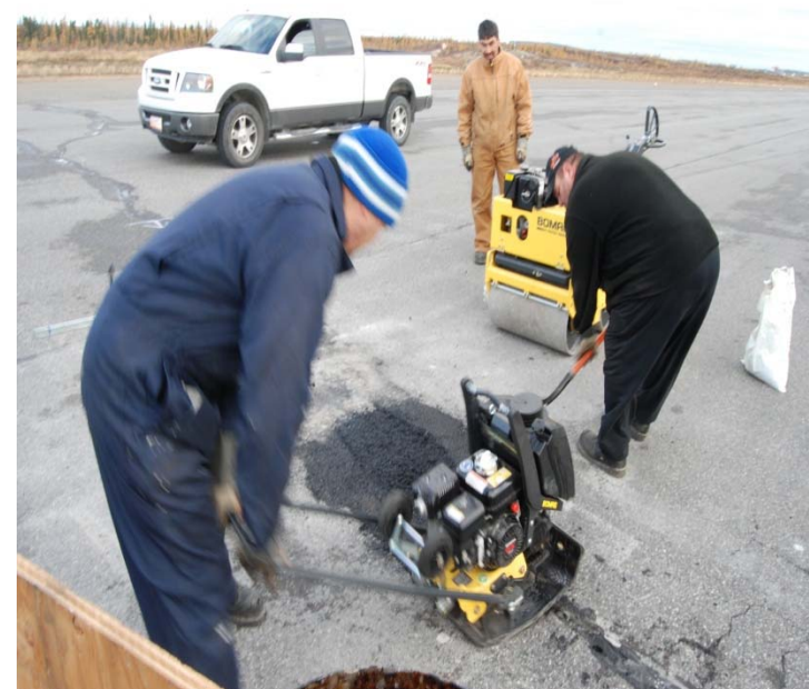
Compaction des bords de la réparation / Compaction of the edges of the repair .
