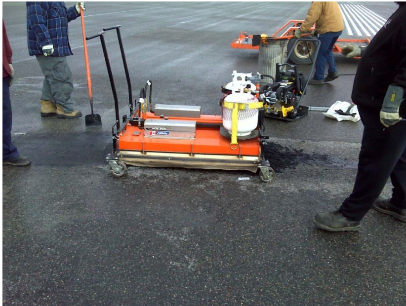
Chauffage du pavage existant / Heating of the existing pavement.
