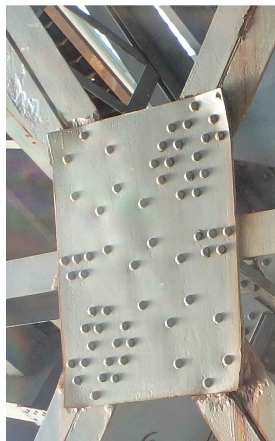
EXISTING CENTRE GUSSET PLATE (DETAIL "A") / GOUSSET CENTRAL EXISTANT (DÉTAIL «A») 1:15
