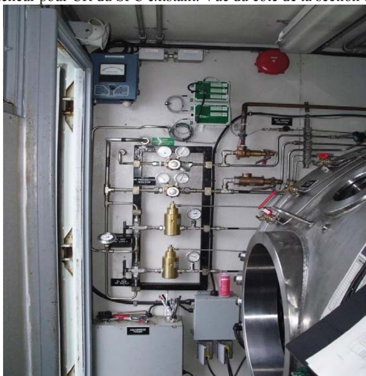
Figure 5 : Vue de l'intérieur de la cloison séparant la section du compresseur de la section de la CR dans le conteneur pour CR du SPC existant. Vue du côté de la section de la CR.
