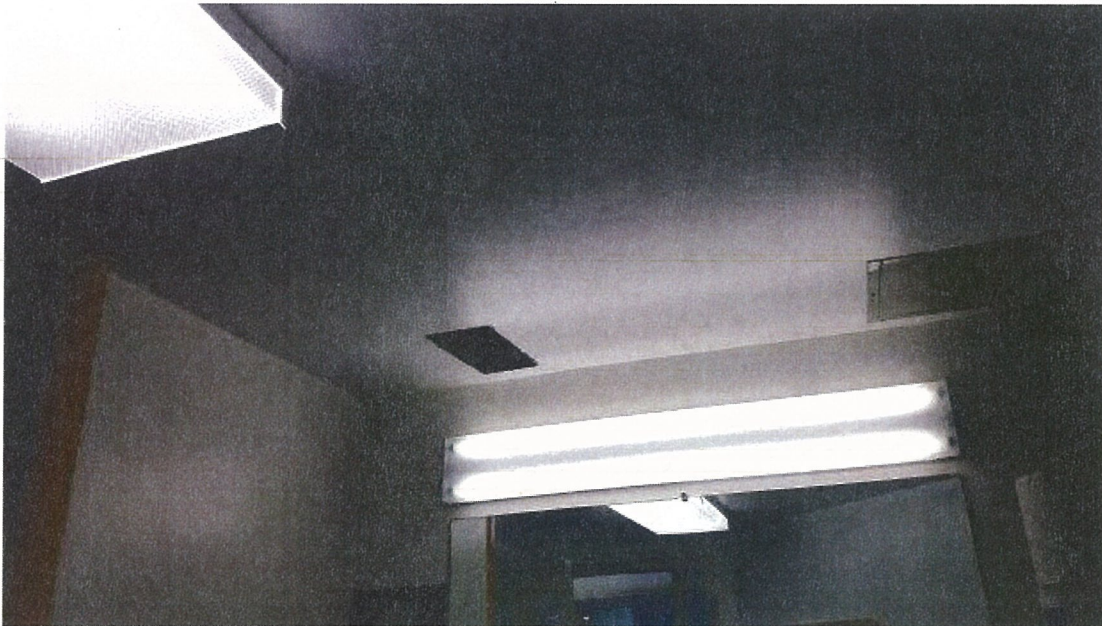
Drywall in barber shop (Room 245).
