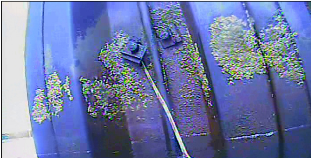
BOULON QUI EST LÂCHE SUR LA FACE NORD DU QUAI AU CHAINAGE 0 +162,5M.
