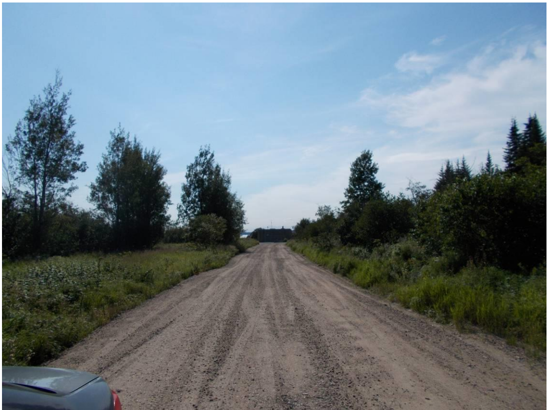
Photographie 4 : Vue vers le nord, station de contrôle des eaux usées de la Ville de Sept-Îles
