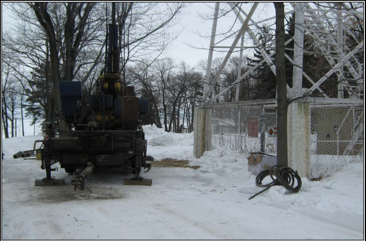
Photographie no 3 : Installation de la foreuse.
