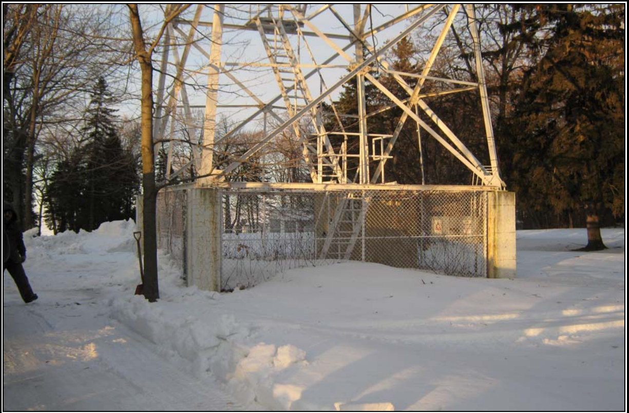
Photographie no 1 : Site avant le début des travaux. Vue en direction sud-ouest.
