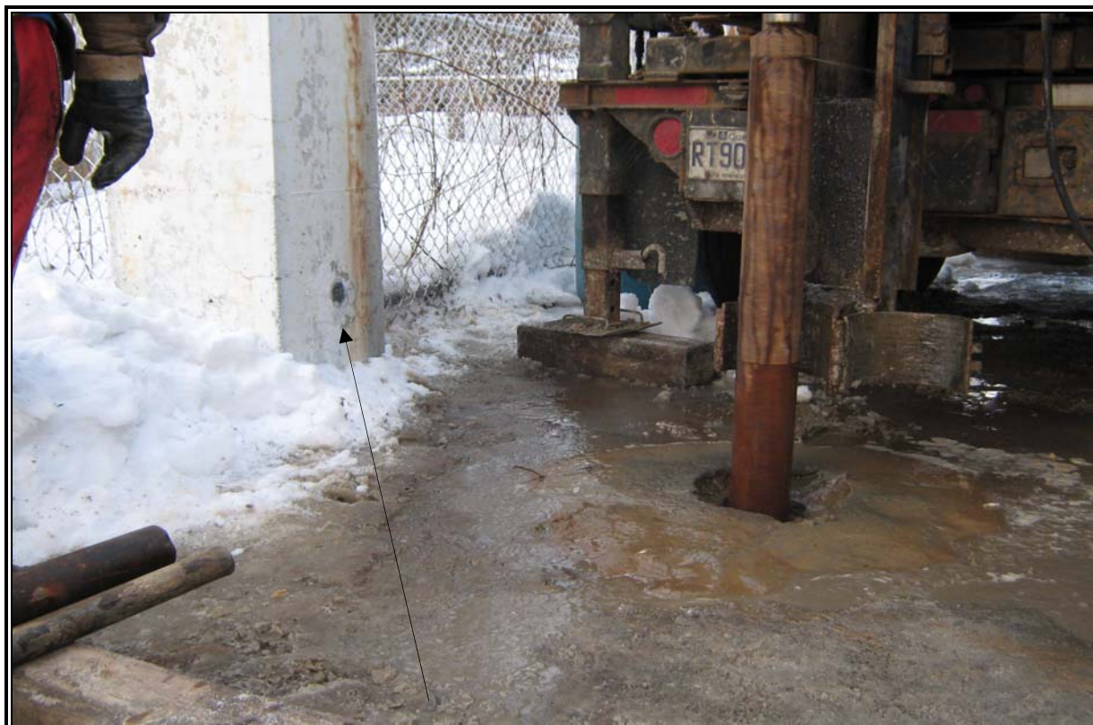
Photographie no 6 : Réalisation du forage F-01A et emplacement du repère de nivellement sur la base sud.
