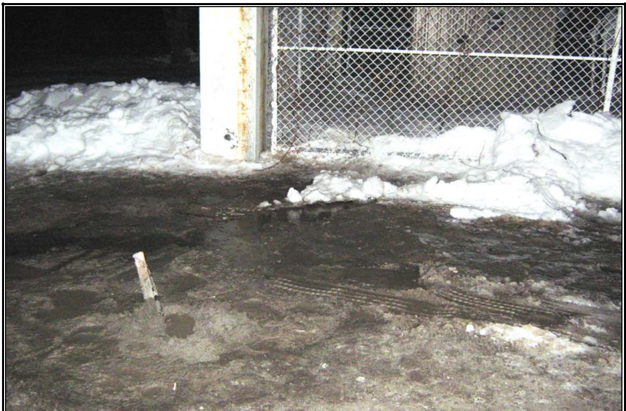
Photographie no 8 : Emplacement du forage F-01. Site après les travaux.
