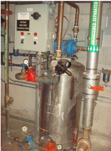
Figure 13 : Système de filtration Vortisand (N° de série MR161) dans la chambre mécanique M4
