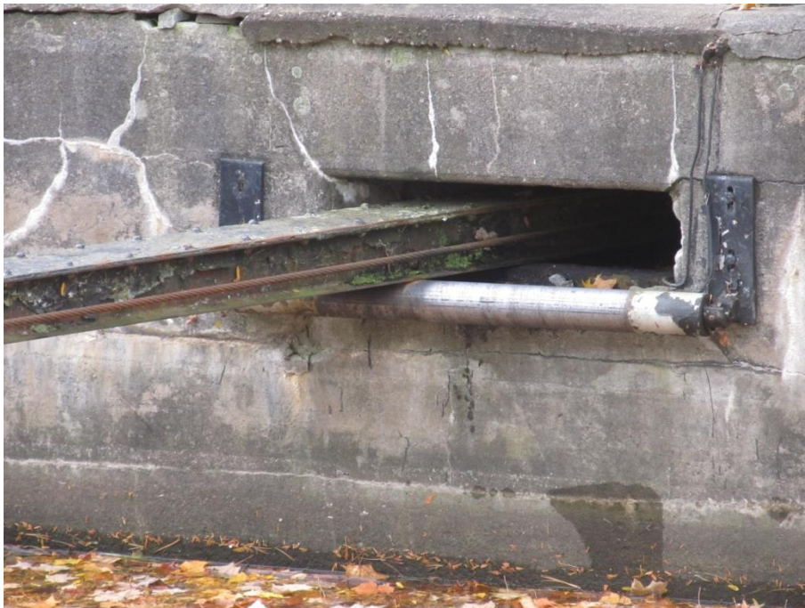
(P10) Écluse 25- Mécanisme de Poste de contrôle et Bar de Rouleau pour écluse de NO
