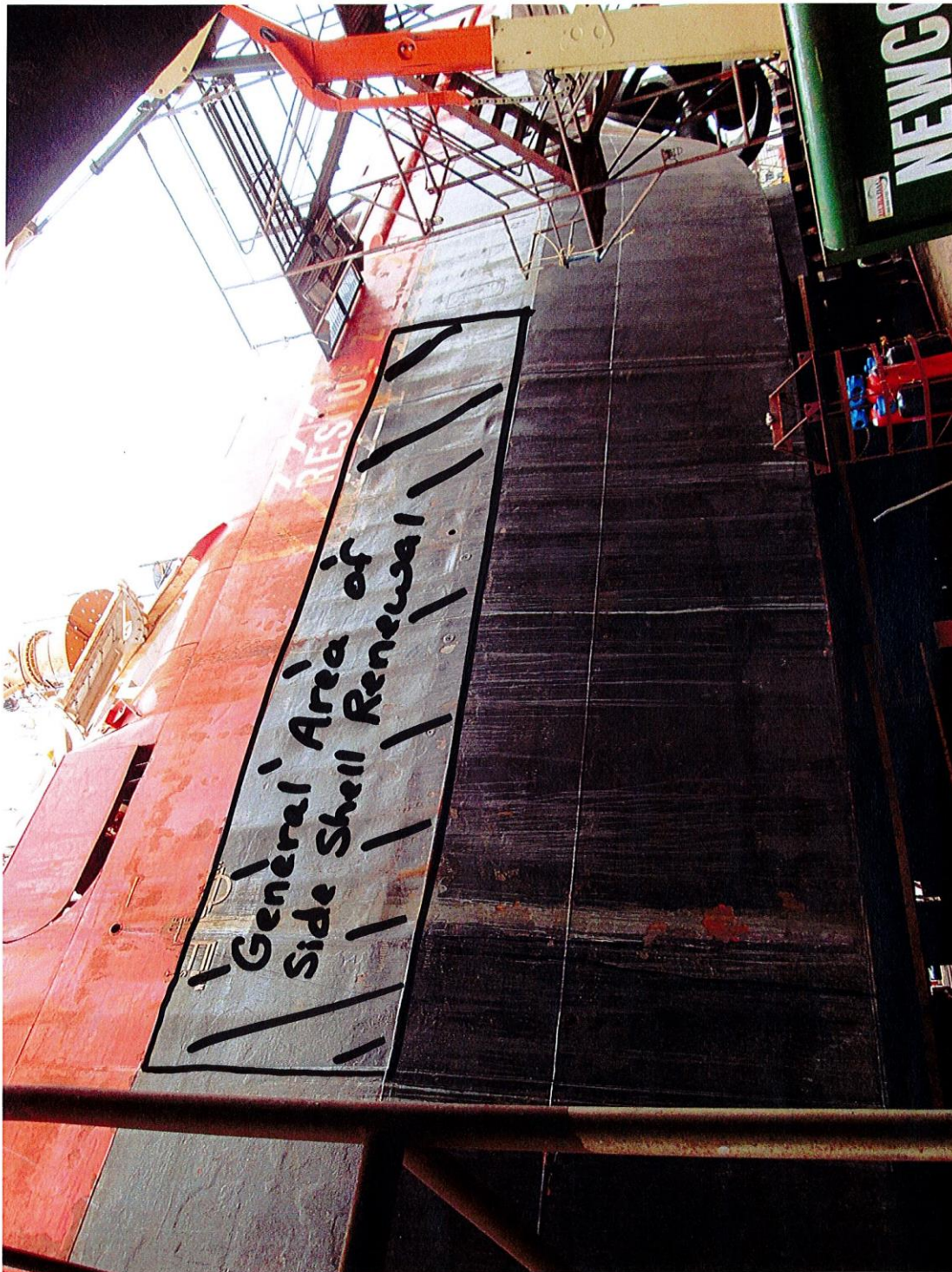
Photographie n° 10 : Vue générale de la zone de renouvellement de la muraille. Côté bâbord illustré, côté tribord semblable
