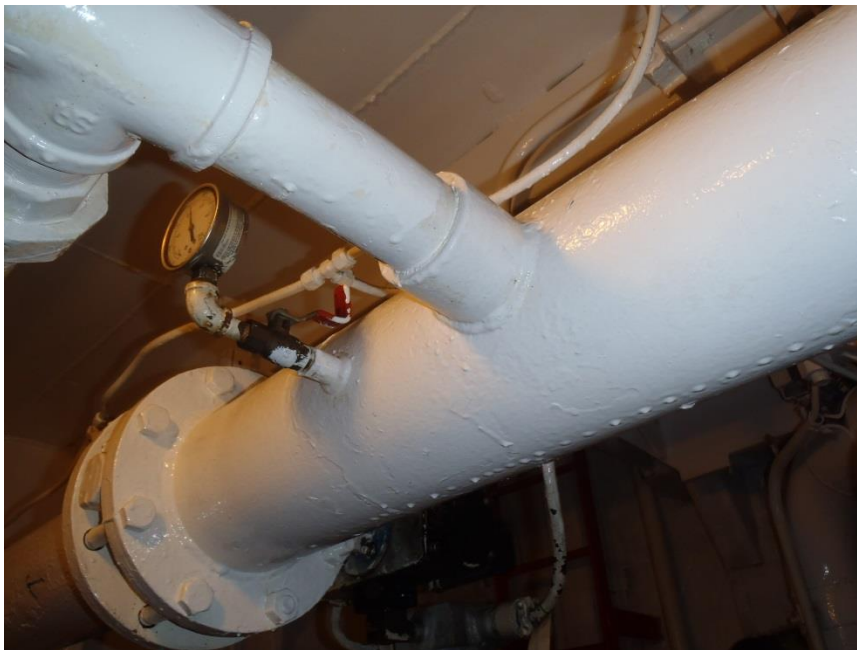
Raccord de 2 po à la tuyauterie de 6 po.
