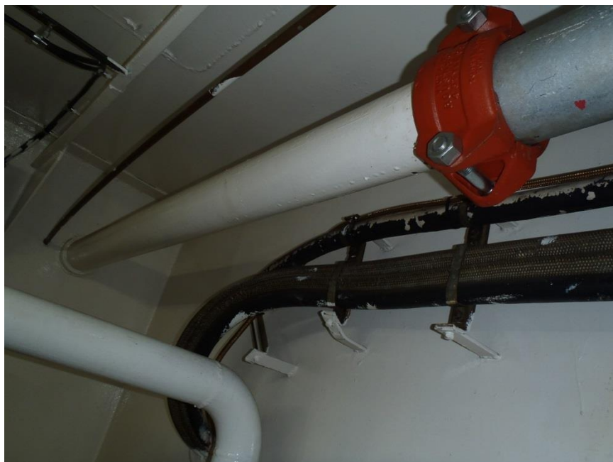
Tuyau de ventilation des eaux usées qui relie le raccord Roust-A-Bout et la cloison du compartiment des eaux usées de bâbord
