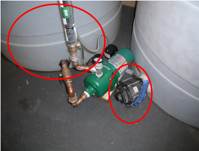
Drain et robinet de vidange du réservoir de stockage des eaux usées
