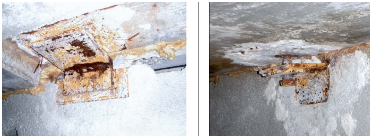
Fig. 9 – À gauche, un raccordement par gravité d'un panneau à fenêtre double, suspendu à la partie supérieure de la dalle au-dessus. À droite, un raccordement latéral d'un panneau à fenêtre double. Les résidus de couleur blanche autour des pièces d'ancrage proviennent de l'ignifugation contenant de l'amiante qui a été enlevé. Photographies tirées du rapport d'étude intitulé Panel Anchor Investigation Report (RMA et Cooke, 2011).
