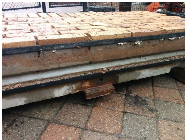
Fig. 8 – Manchon fileté observé sur la plaque de raccordement par gravité au centre.
