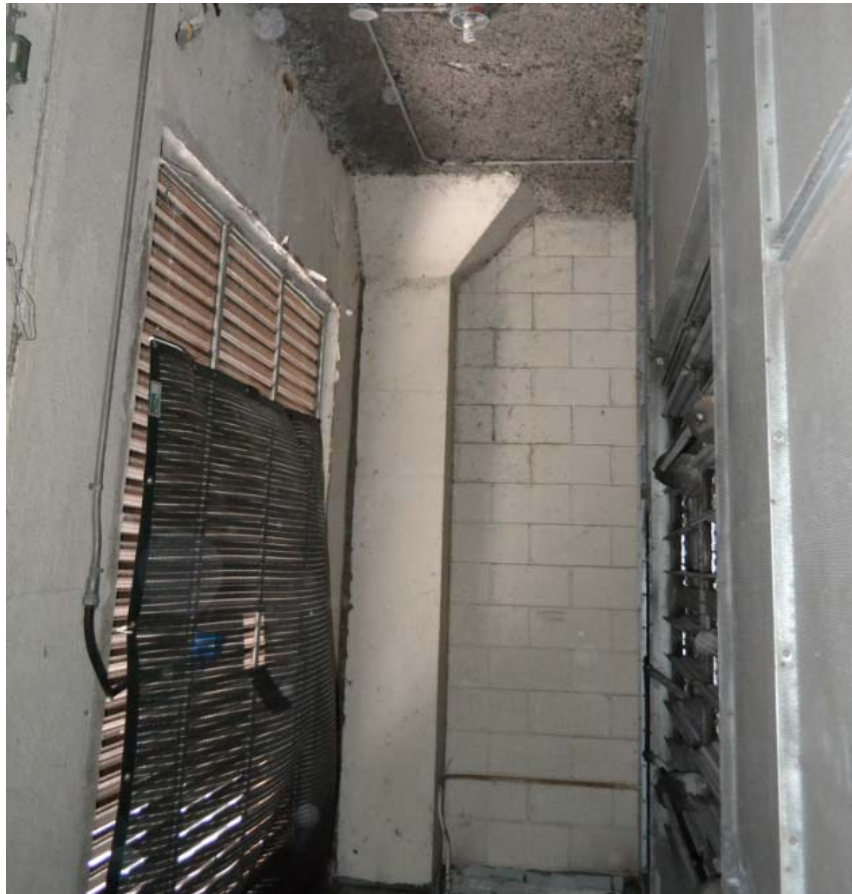
Fig. 14 – Cavité murale entre les louveres extérieurs et l'appareil de traitement d'air. Le grillage à mailles suspendu sert à capter les débris et peut être une indication que les louveres ne sont pas assez grands. Pour la nouvelle façade, on devrait considérer augmenter les dimensions des louveres.
