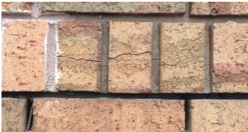
Fig. 2 – Fissuration dans la brique dans l'assise de briques de champ au bas du panneau. À gauche, le mortier utilisé pour une réparation qui vient d'être effectuée.
