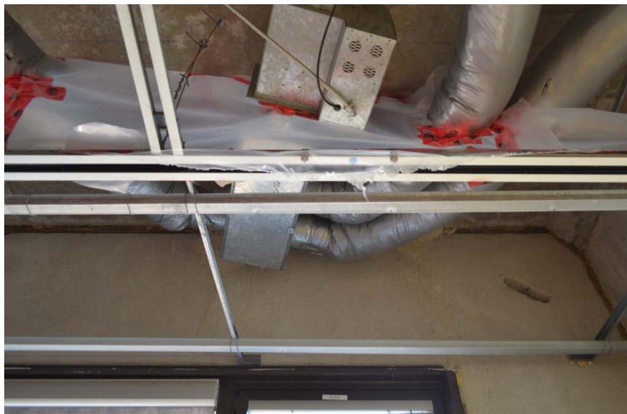
Fig. 13 – Intérieur d'un bureau type avec plafond et cloisons sèches enlevés. Les conduits d'air sont près du mur extérieur, mais ils n'y sont pas assujettis.
