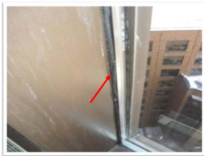
Fig. 11 – Le produit de calfeutrage des fenêtres dans l'ensemble du complexe est reconnu comme renfermant de l'amiante.
