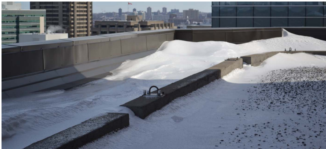
Fig. 41 – Parapet du 25, rue Eddy, avec ses rails en périmètre dotés d'ancrages de positionnement. Les ancres ne conviennent pas à la fixation de cordages de sécurité.
