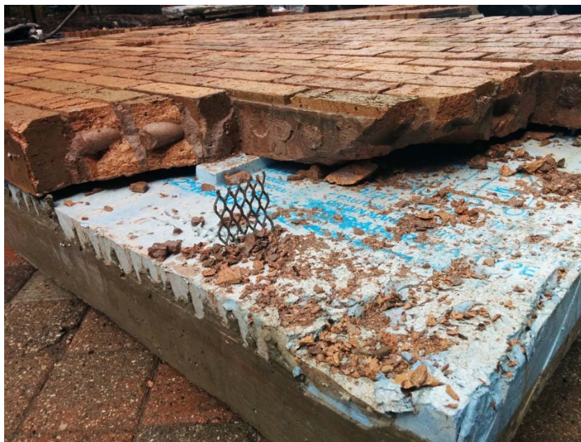
Fig. 6 – Supports en acier et briques jointoyées sur un subjectile préfabriqué isolé. Noter les ailettes de cisaillement en acier déployé qui supportent le placage de briques ainsi qu'une bande d'isolant rigide (tout juste derrière l'ailette) produisant ainsi une lame d'air.
