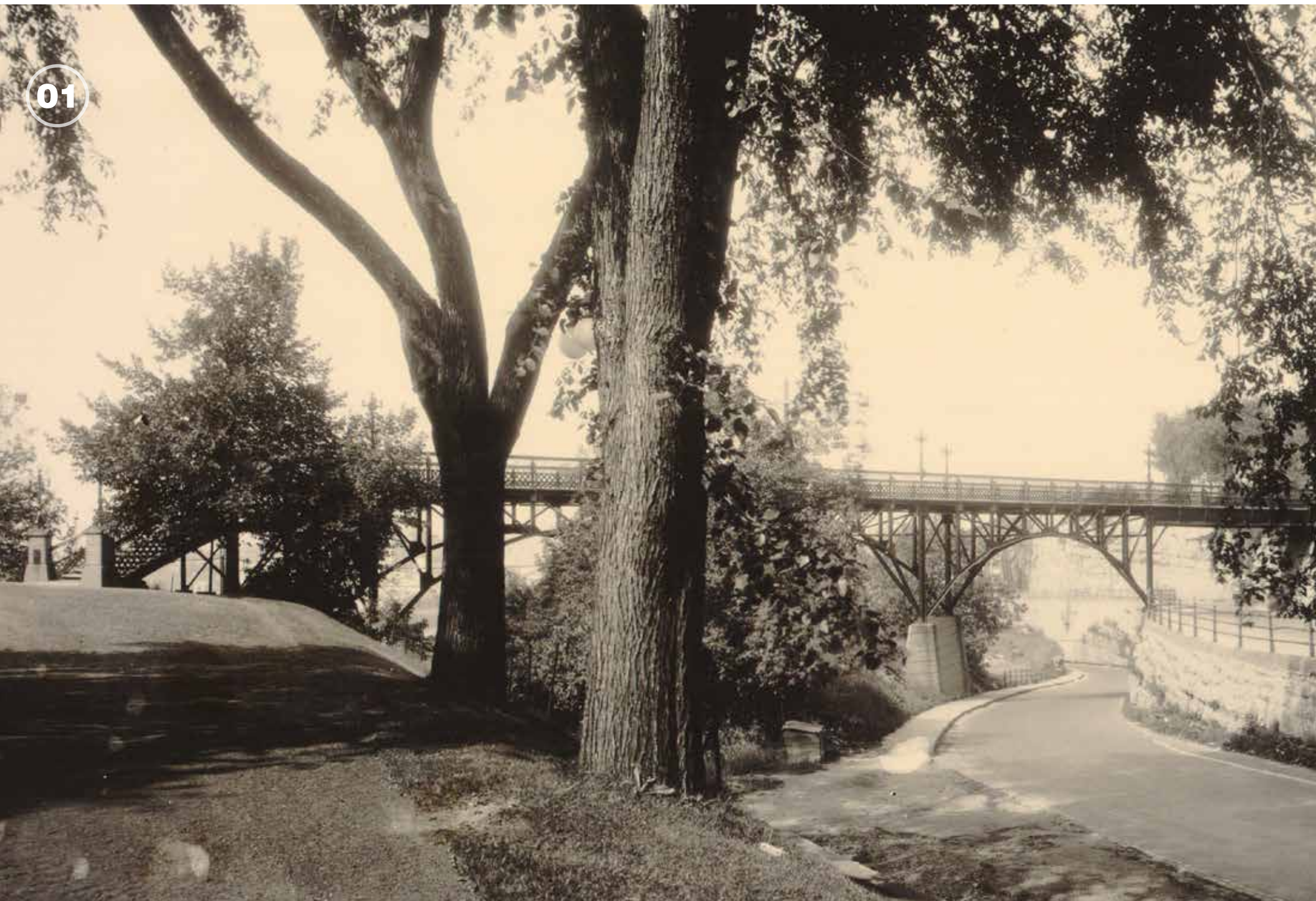
Pont en fer décoratif reliant la pointe Nepean et le parc Major's Hill, vers les années 1940
