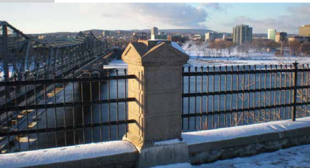
Mur de maçonnerie avec clôture en fer
