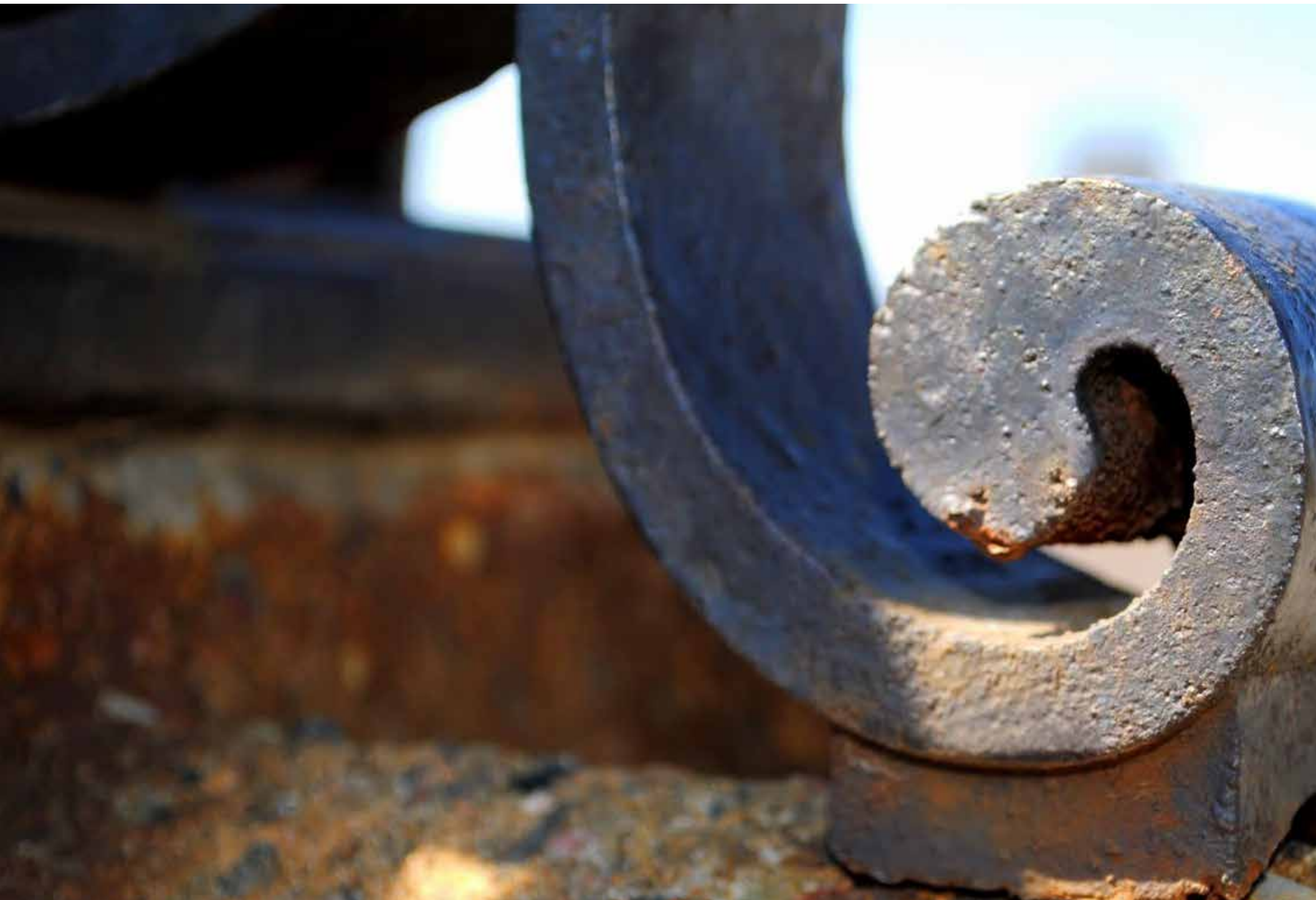
La pointe Nepean - une vue détaillée de la clôture existante
