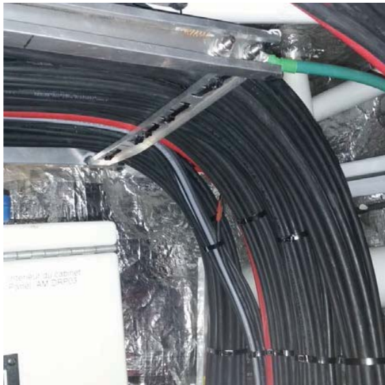
Figure 6: obstruction passe cloison salle de contrôle
