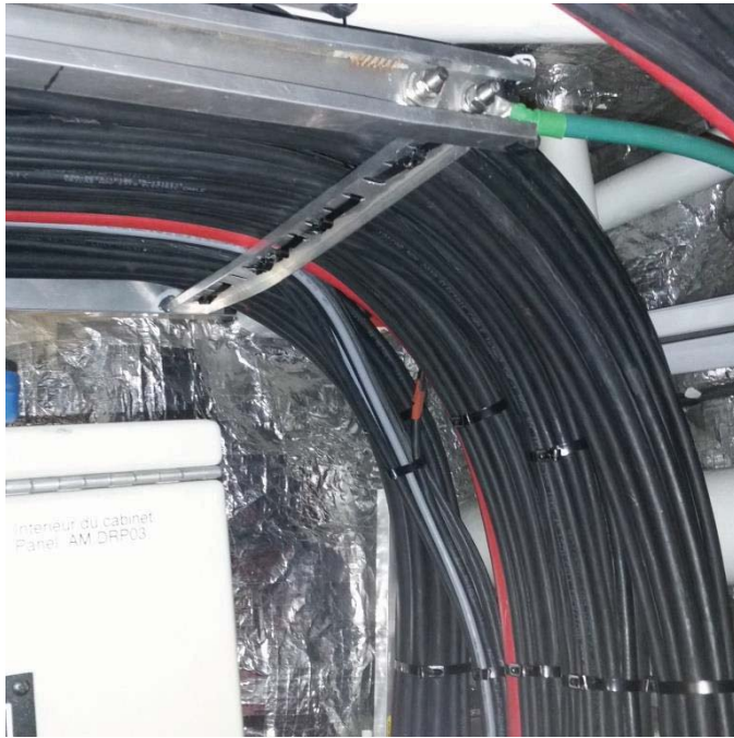
Figure 1: obstruction passe cloison salle de contrôle
