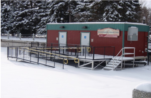
5 th Ave Washroom Chalet / Chalet des toilettes de la 5e Avenue
