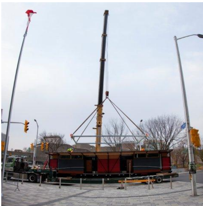
Picture illustration the lifting operation at Rideau Rest Area / Operation de levage précédente
