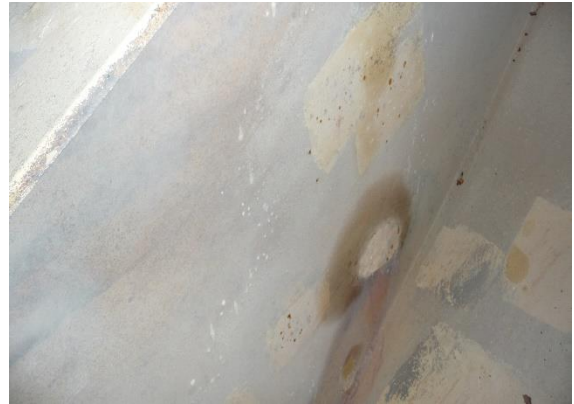
16. Web blister corrosion.
